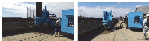
図3 サイレントパイラーによる鋼矢板圧入状況
