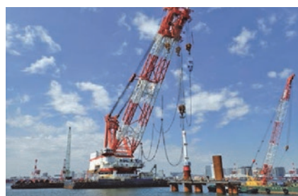
写真3 鋼管杭打設状況
