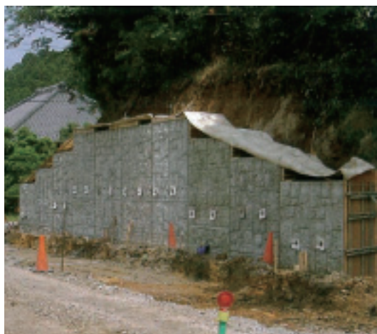
写真5.1 コンクリートパネルを用いた施工事例
