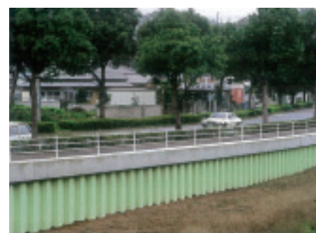
写真5.3 有機ライニング塗装を用いた施工事例
