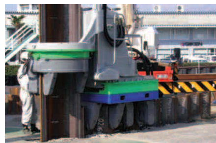
写真-3 ハット形鋼矢板900圧入機(試作機)
