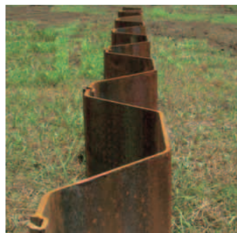
写真1 ハット形鋼矢板打設後状況
