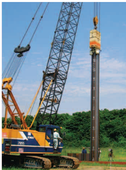
写真-2 パイプロ施工試験状況
