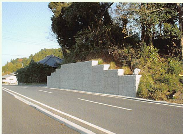
修景方法：コンクリートパネル
