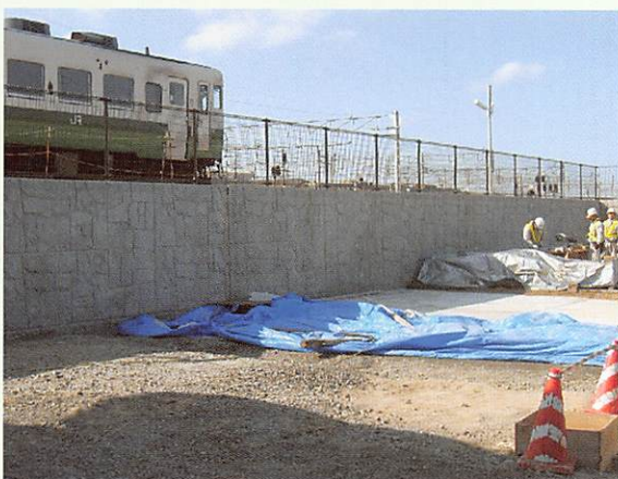
修景方法：コンクリートパネル
