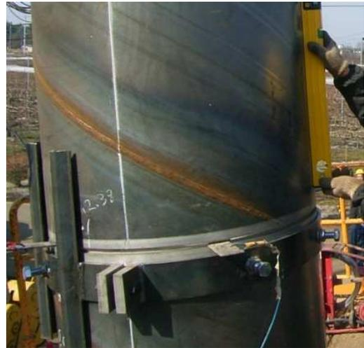
写真-4.8 現場溶接用治具の例
