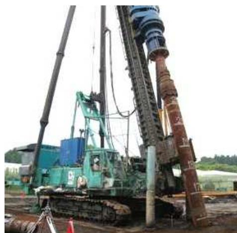
写真－4.7 斜杭の施工状況
