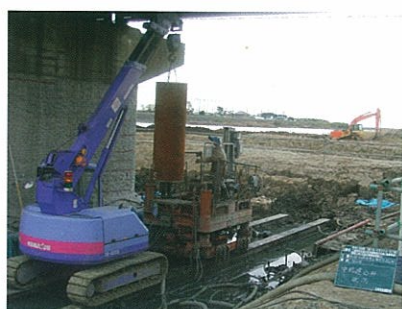
鋼管増し杭基礎の桁下施工による事例
