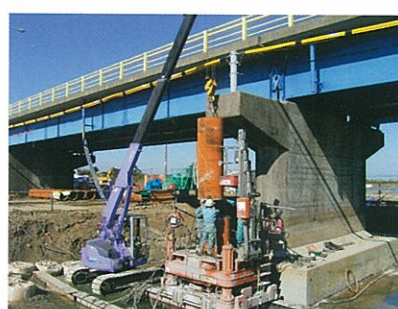
鋼管増し杭基礎の桁下施工による事例
