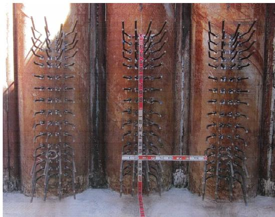
写真 5-1 出来形(取付位置、取付間隔)測定例
