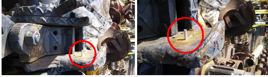
アルミ棒挿入状況
