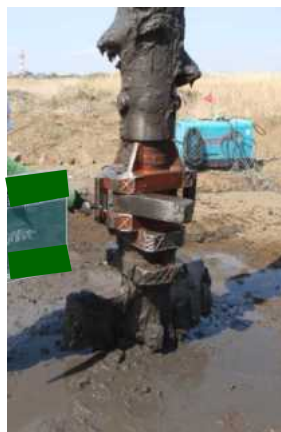
拡翼確認（全景）写真記録
