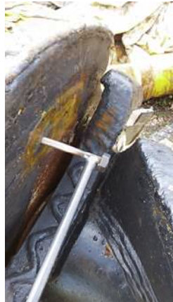
切断アルミ棒抜き取り状況
