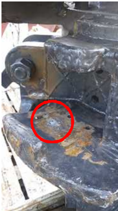
拡翼完了後アルミ棒切断状況
