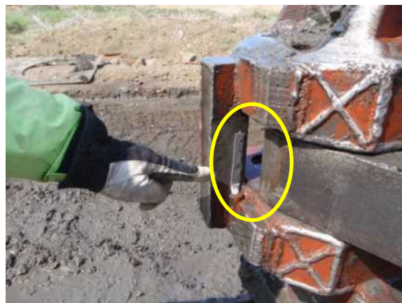
拡翼確認（接写）写真記録
