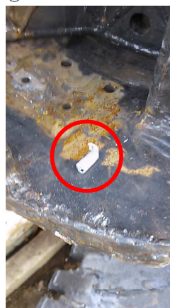
アルミ棒抜き取り後状況
