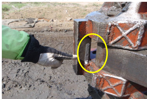
拡大翼確認（接写）写真記録
