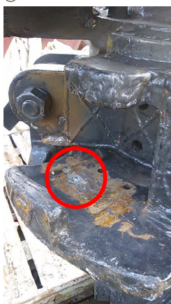
拡翼完了後アルミ棒切断状況
