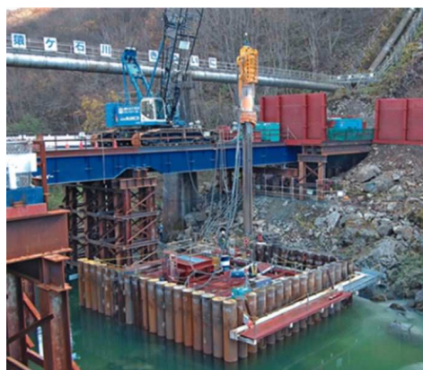
図-G.4.2 クレーンによる吊り下げ施工
