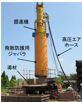
図-G.4.2 クレーンによる吊り下げ施工
