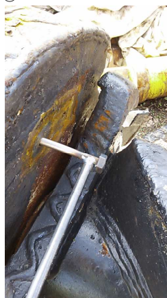
切断アルミ棒抜き取り状況
