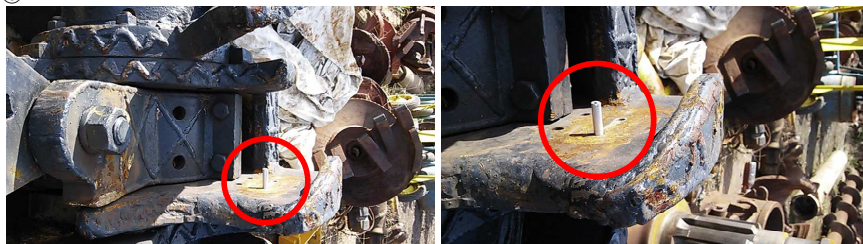
アルミ棒挿入状況
