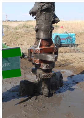
拡大翼確認（全景）写真記録
