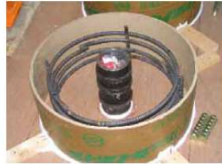
写真 2-1 コンクリート打設前の状況
