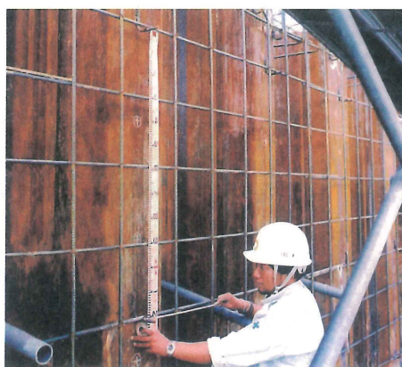
参考 図 7.5 場所打ちコンクリートを用いた施工事例
