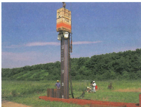
参考 図 2.1 鋼矢板の施工方法（左：バイブロハンマ 右：油圧圧入機）
