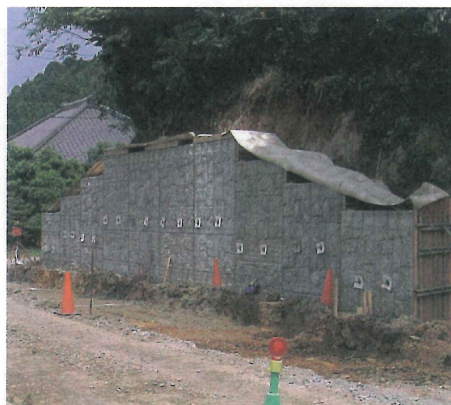
参考 図 7.4 コンクリートパネルを用いた施工事例
