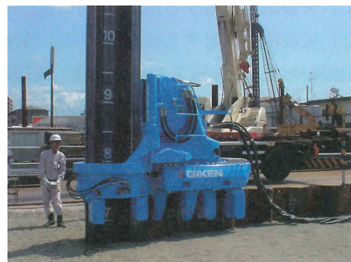
参考 図 2.1 鋼矢板の施工方法（左：バイブロハンマ 右：油圧圧入機）
