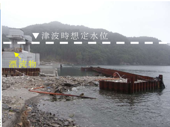
写真 5.3.3 全景 (水門より海側)
