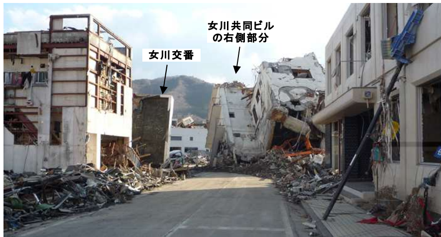
写真 3.2.2 国道 398 号線を塞ぐ女川共同ビル 3.6)
