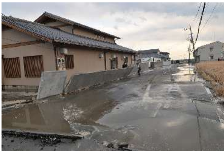
写真 3.2.2 液状化による被害① (噴砂とブロック塀の傾斜：潮来市日の出)
