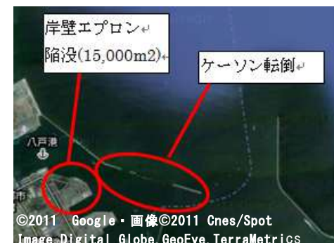
写真 3.2.15 八戸港 河原木の被災状況 (岸壁エプロン陥没・ケーソン転倒)
