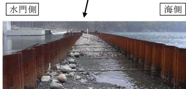
写真 3.4.12 二重鋼矢板仮締切り堤 4) (調査対象②(釜石市)、鋼矢板損傷なし)
