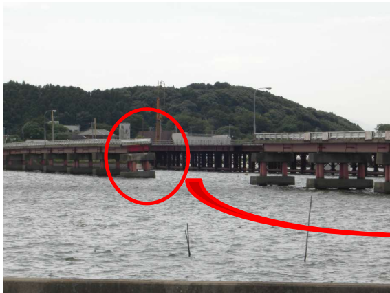
詳細写真7(落橋箇所拡大、旧橋東側より 橋脚南方向に傾斜?)
