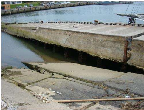
孕み出し部背面のH鋼
