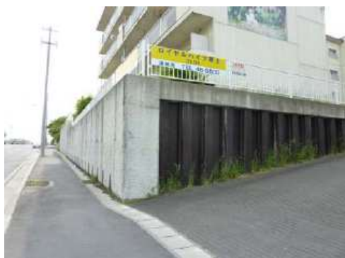
写真 3.4.9 道路擁壁 (調査対象①(八戸市)、無被災)
