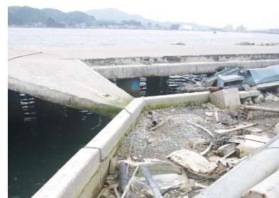
写真 3.3.21 気仙沼漁協の被災状況(2) (渡版の落下・破損)
