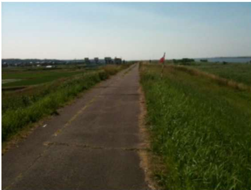
詳細写真3 (地点⑤、耐震対策箇所、被災なし)
