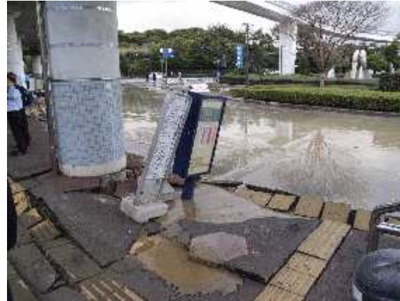
写真 3.2.5 液状化による被害④ (噴砂と地盤沈下：浦安市舞浜駅前)
