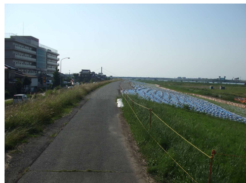
写真 3.4.3 利根川右岸 39km 近傍 (無対策区間、応急復旧後)
