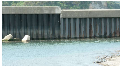
写真 3.3.8 久慈川河口の導流堤
