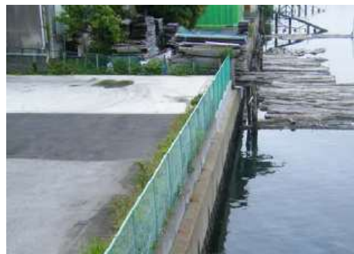
写真 3.4.8 新木場 護岸 (調査地点 2、無被災)
