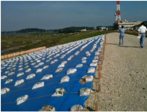
詳細写真6 (地点②、無対策箇所、応急復旧済)
