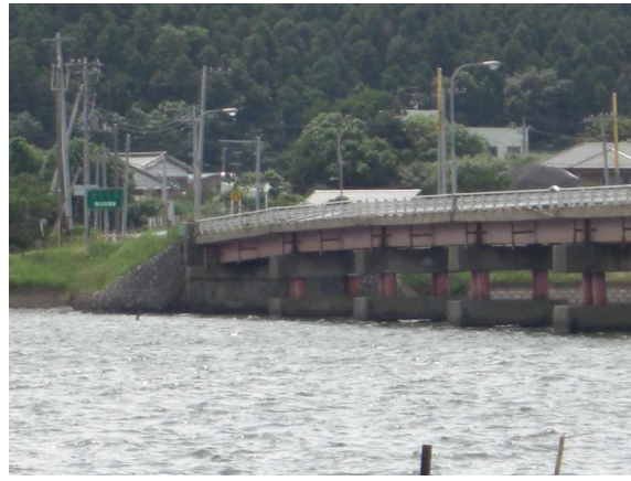
詳細写真7(落橋箇所拡大、旧橋東側より 橋脚南方向に傾斜?)
