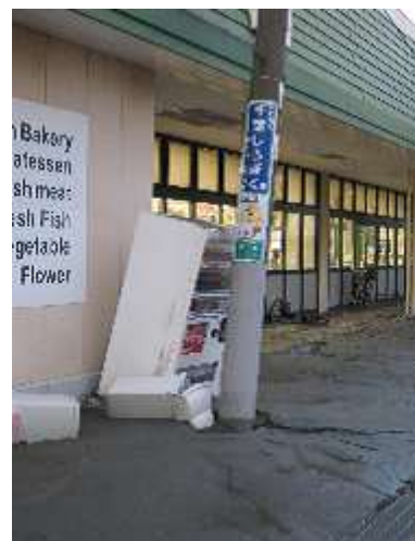
写真 3.2.3 液状化による被害② (噴砂と地盤沈下：千葉市美浜区)
