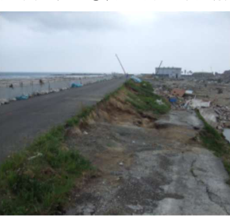
詳細写真1 (地点①、堤内側 のり面の崩壊)
