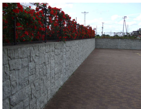
写真 3.4.10 道路擁壁 (調査対象②(美里町)、無被災)
