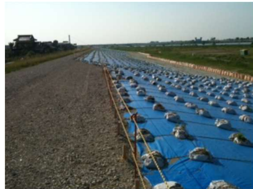
詳細写真5 (地点②、無対策箇所、応急復旧済)
