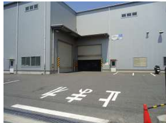
写真 3.2.9 支持地盤まで基礎杭を設置した建物② (浦安市千鳥)
