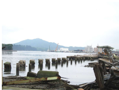
写真 3.3.20 気仙沼漁協の被災状況(1) (棧橋上部工の流出)
