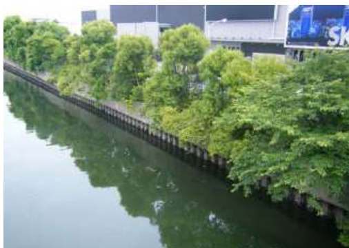
写真 3.4.7 新木場 護岸 (調査地点 1、無被災)
