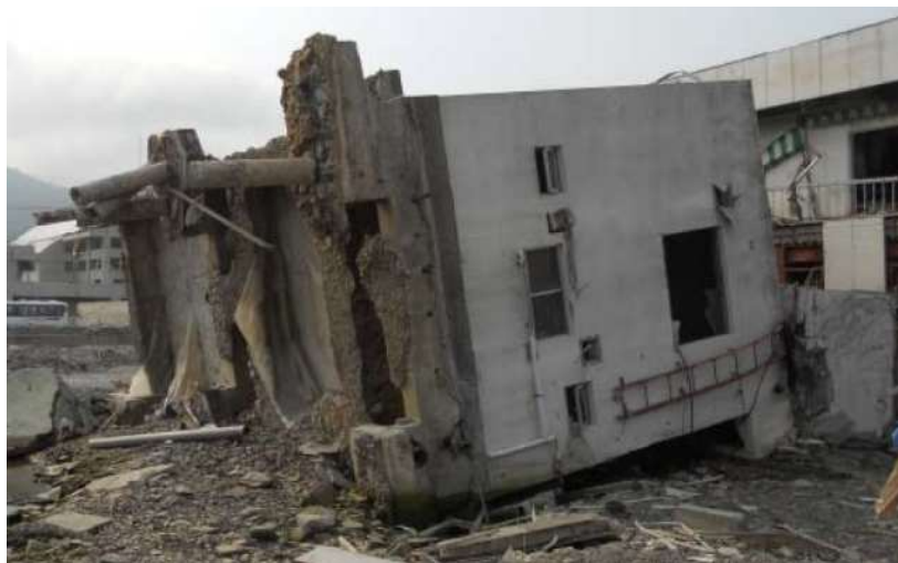
写真 3.2.1 津波により転倒した RC 造建物（女川町）
