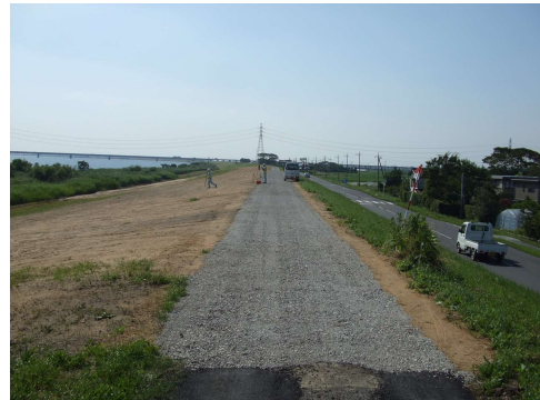
写真 3.4.2 利根川左岸 32.25km 近傍 (止水矢板区間、応急復旧後)
