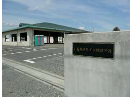
写真 3.2.15 近接構造物の被害状況
