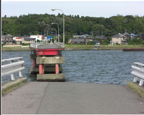
詳細写真7(落橋箇所拡大、旧橋東側より 橋脚南方向に傾斜?)
