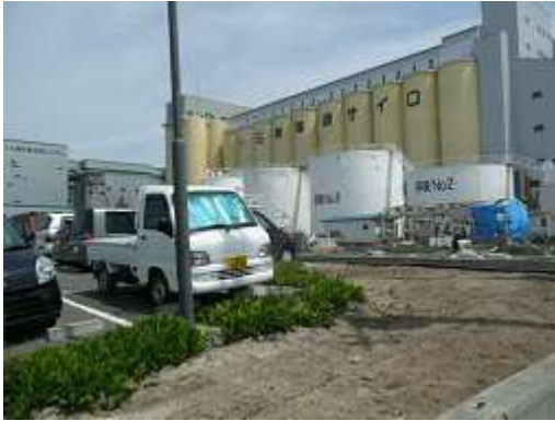
写真 3.2.14 原料サイロ 建物全景
