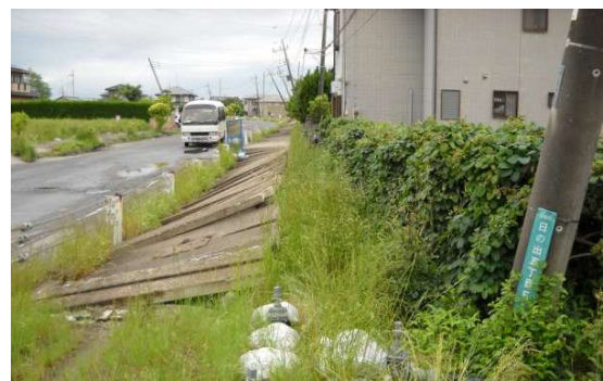
写真 2.2 潮来市・日の出の液状化被害（6/14 撮影，3 か月後にも大きな爪痕が残る）
