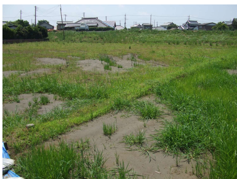
写真 3.4.5 横利根川 (護岸背面の液状化跡)
