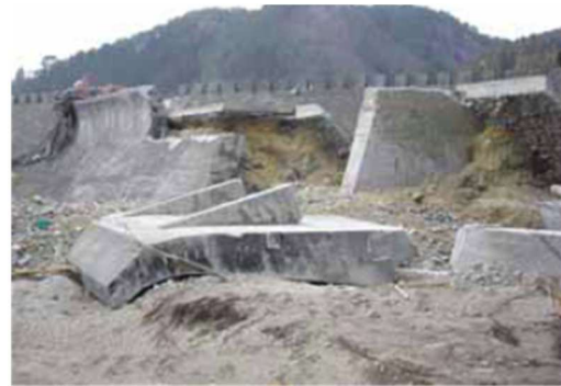
写真 2.3 田老地区の防潮堤被害 9)
