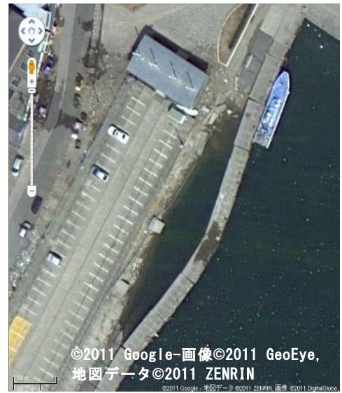
写真 3.3.28 那珂湊漁港の被災状況(1)
