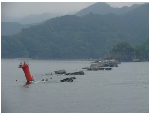
写真 3.3.1 釜石湾口防波堤の被害
