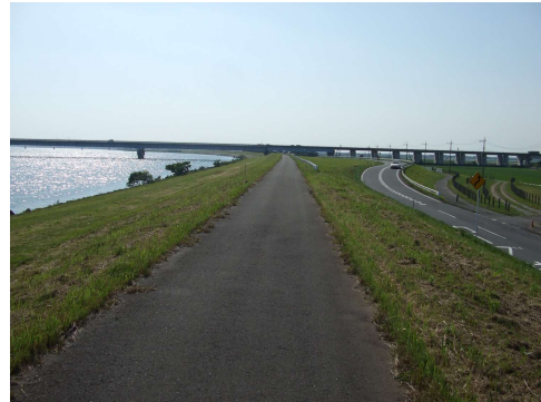
写真 3.4.1 利根川左岸 33.25km 近傍 (耐震対策区間、無被災)
