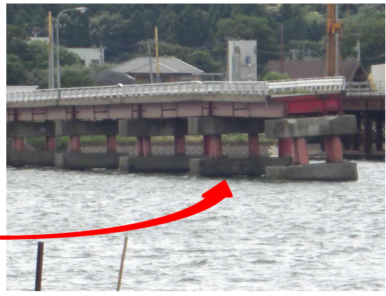
詳細写真7(落橋箇所拡大、旧橋東側より 橋脚南方向に傾斜?)
