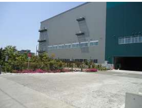
写真 3.2.8 支持地盤まで基礎杭を設置した建物① (浦安市千鳥)
