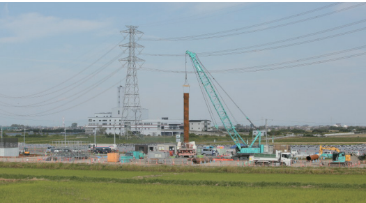
■場所打ち杭が適用できない施工地の課題をクリアした回転杭
