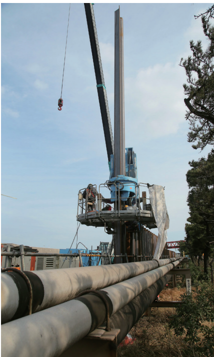
■鋼矢板の打設状況
