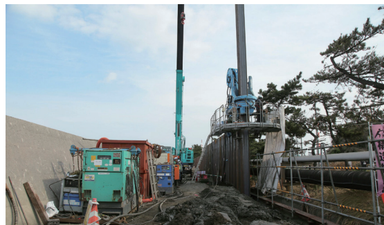
■鋼矢板の打設状況
