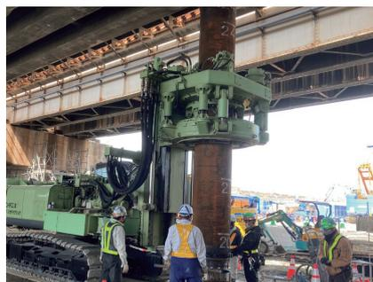
■ 低空頭・狭隘地施工機による回転杭の施工状況
