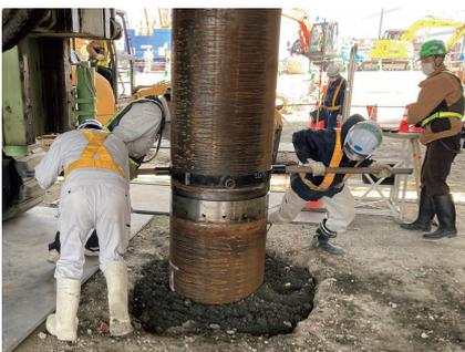
■ 機械式継手の施工状況
