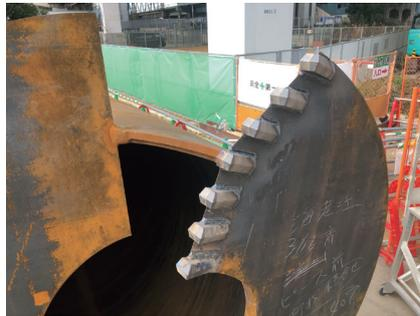
■回転杭、先端掘削補助刃
