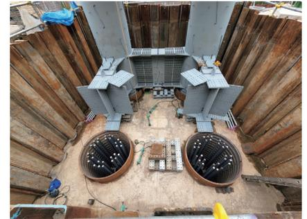
■鋼管集成橋脚、基部の架設状況
