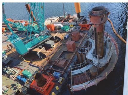
■鋼管矢板基礎の打設状況
