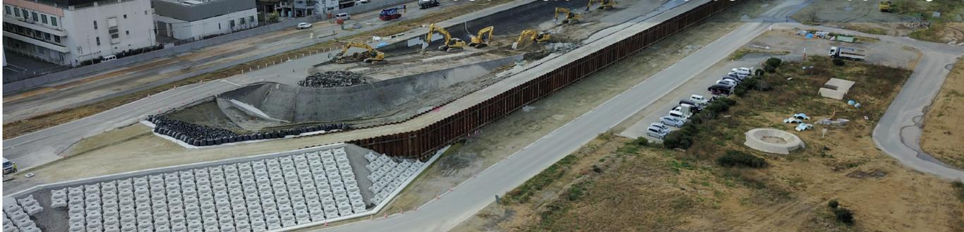
■ 淀川左岸線（2期）仮設堤防築造における、鋼矢板二重締切りの施工状況
