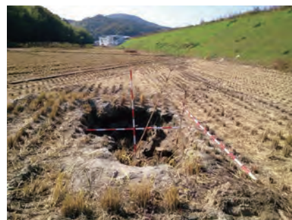
■小田川右岸 1.6km 付近 噴砂の状況
