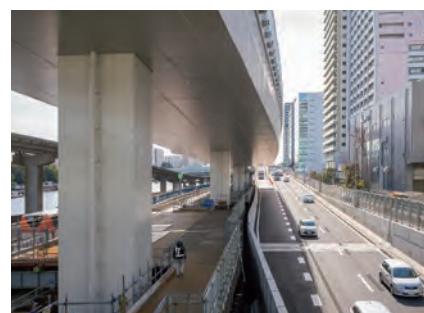
■東品川橋部、迂回路と更新1期線の現況
