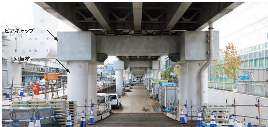
■回転杭を用いて施工された迂回路の桁下空間は長期間の工事用道路としても活用されている
