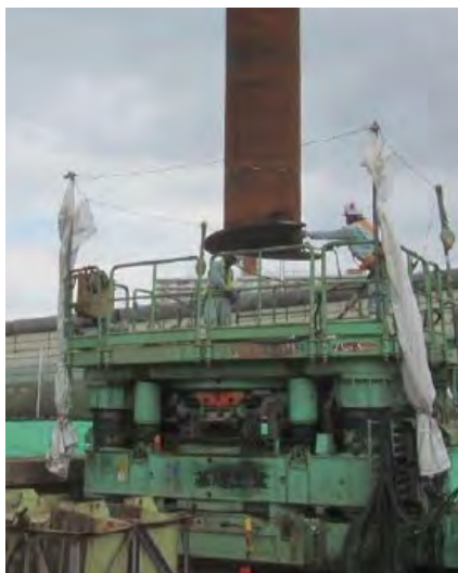
■回転杭の建込み状況
