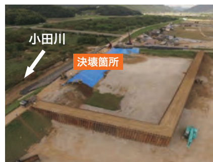
■完成した鋼矢板二重締切（左岸3.4km）
