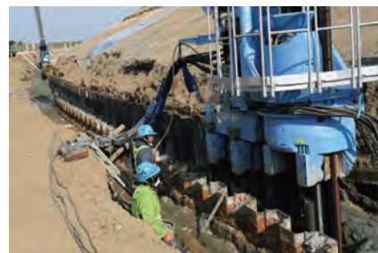
■硬質地盤クリア工法による圧入状況
