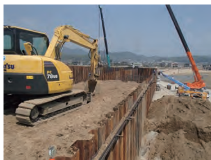
■鋼矢板二重締切後の中詰土、作業状況
