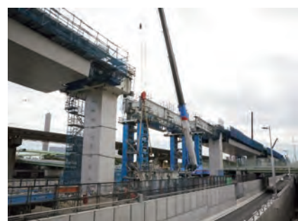
■橋脚一般部の床版・桁架設状況
