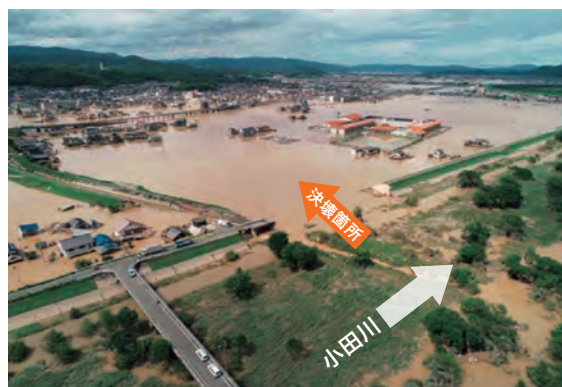
■小田川左岸3.4kmの被害状況（2018年7月7日）
