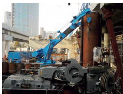
■鋼管矢板の建込み状況（Ⅰ期線・P26橋脚）
