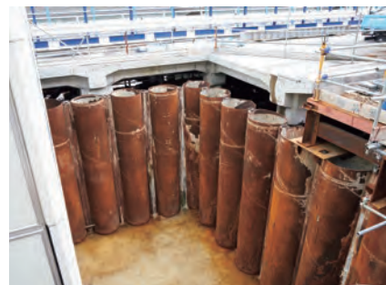
■鋼管矢板基礎 締切り状況
