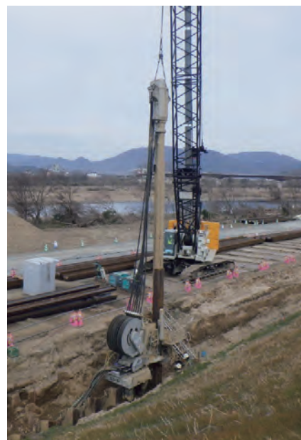
■高梁川・中原地区 硬質地盤クリア工法による圧入状況
