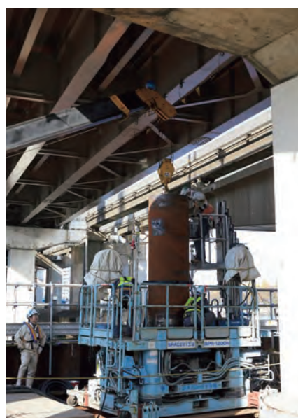
■鋼管杭の圧入状況（Ⅰ期線・P27橋脚）
