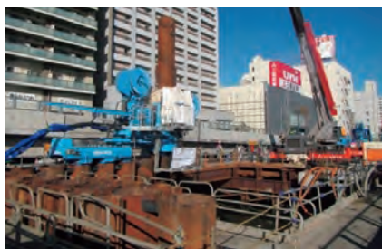
■鋼管矢板基礎 圧入状況
