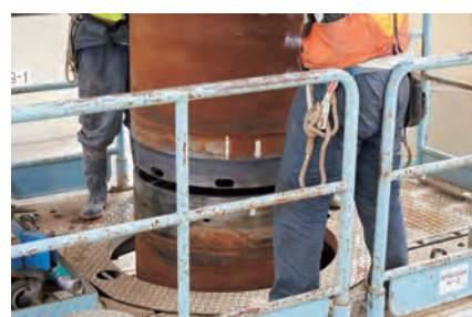
■機械式継手の嵌合状況
