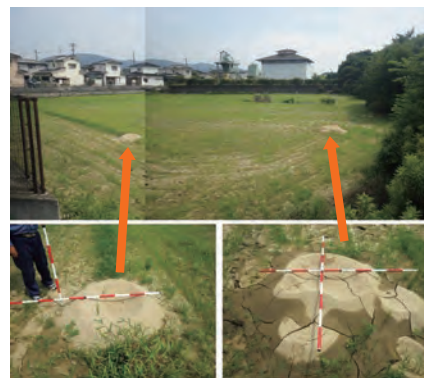
■高梁川左岸 16.5km 付近 噴砂の状況
