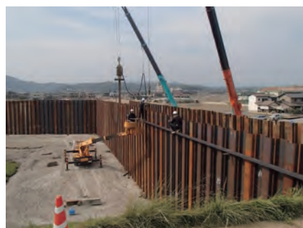
■鋼矢板二重締切の打設状況
