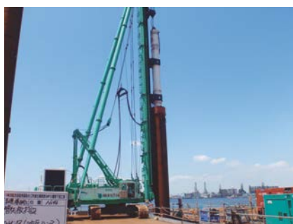
■ MP3での鋼管矢板打設状況
