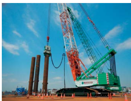
■ MP3での鋼管矢板打設状況
