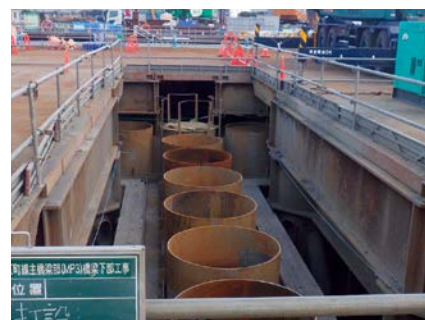
■ 上杭打設後の鋼管矢板 (MP3)
