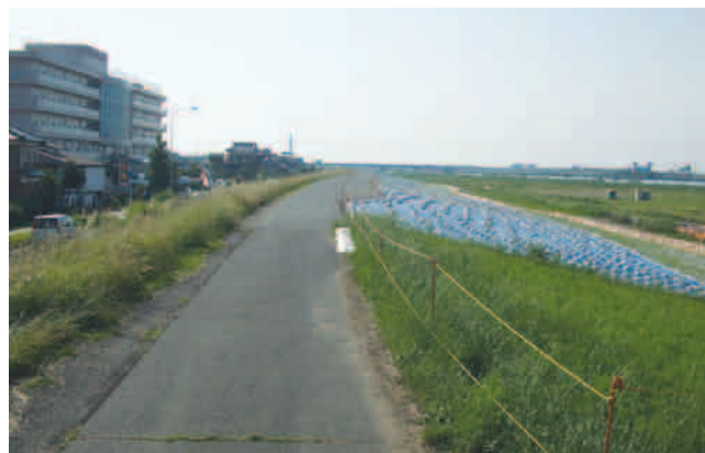
写真2.4.2 利根川右岸39.0km近傍
