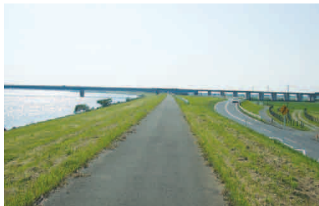
写真2.4.1 利根川左岸33.25km近傍
