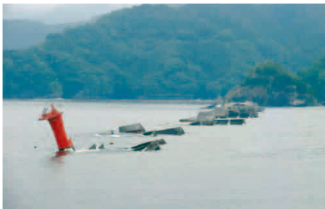
写真2.2.1 釜石湾口防波堤の被害*
