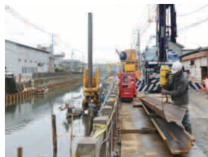
搬入の取り回しから2枚継ぎの鋼矢板を打設する
