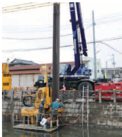
VL形鋼矢板 打設状況
