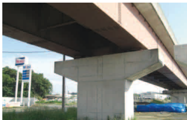
写真2.1.9 宮の下高架橋（回転杭）
