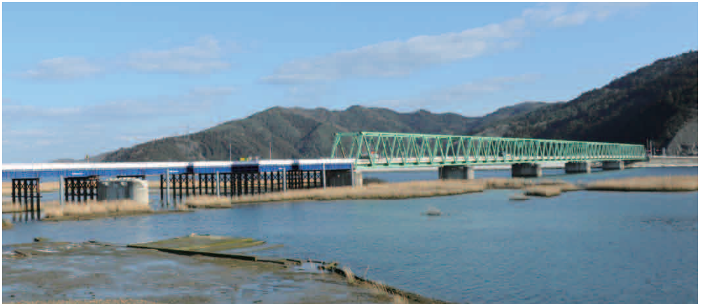
仮橋開通済みの新北上大橋
