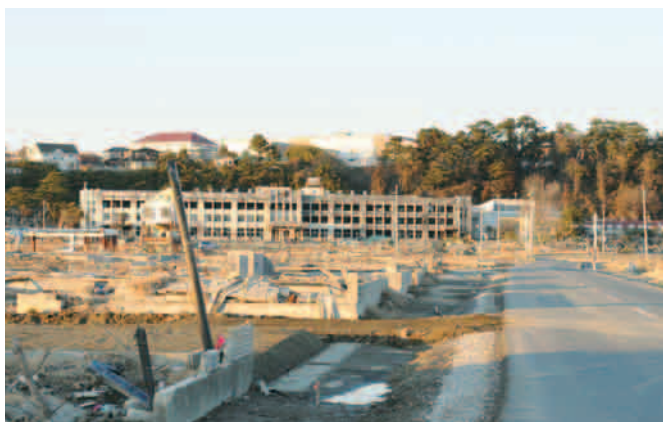
震災後1年が経過、災害の爪跡が生々しく残る石巻市門脇地区
