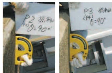
水平器による測定で橋軸・直角とも90度を計測
