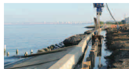
松岸地区 鋼矢板打設状況
