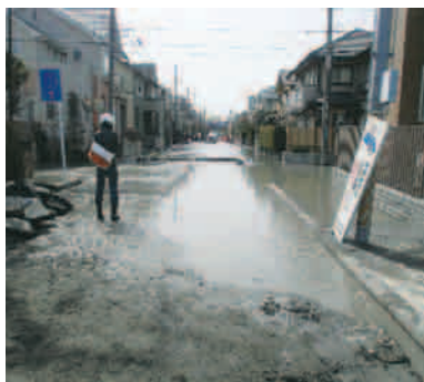
写真2.3.2 液状化被害①*
