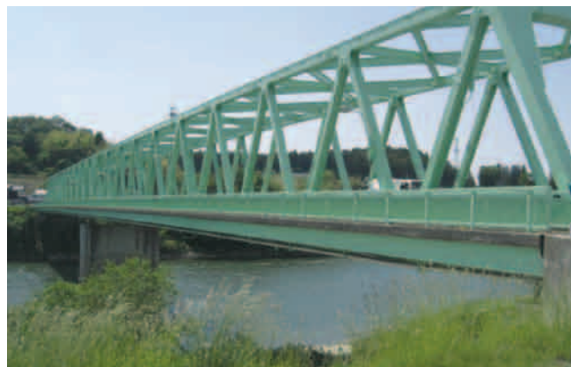
写真2.1.7 米谷大橋（鋼管矢板基礎）
