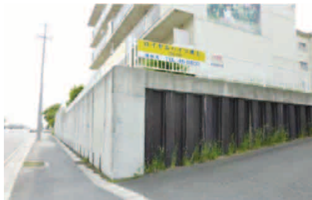
写真2.4.4 道路擁壁（八戸市）
