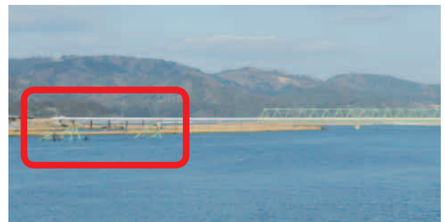
上流700mには流失したトラスが残る
