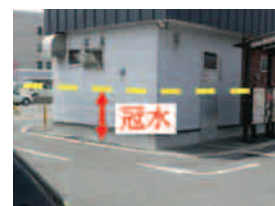
写真2.3.6 近隣建物の冠水痕
