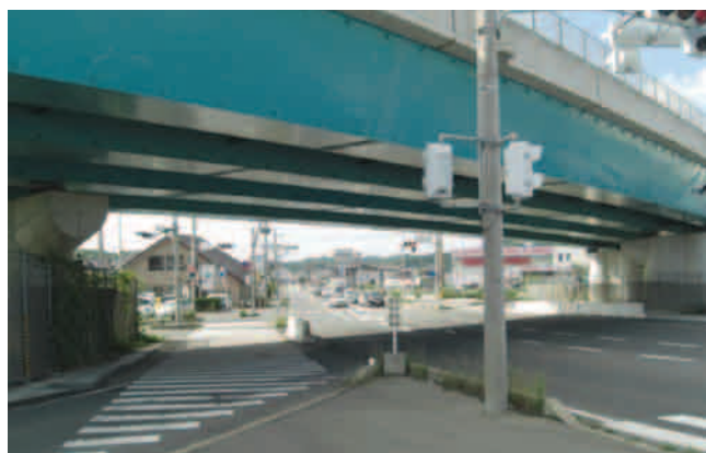
写真2.1.8 磐城バイパス橋梁（鋼管ソイルセメント杭）
