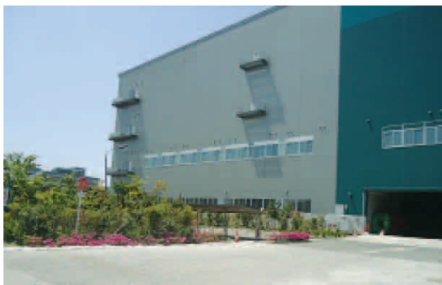
写真2.3.4 支持地盤まで基礎杭を設置した建物（浦安市）
