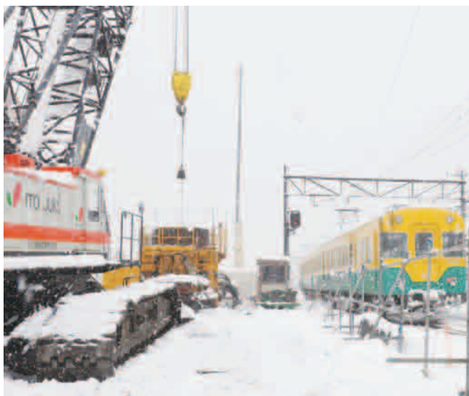
営業線への最接近現場の状況
