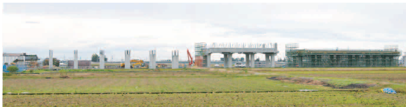
着々と高架橋の立ち上げが進む北陸新幹線（水橋田伏高架橋付近）
