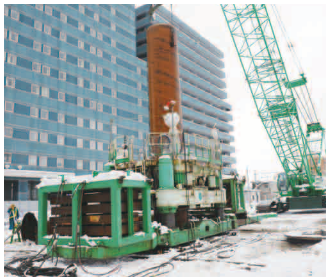
プラント設備や排土置き場が不要のため省スペース施工が可能
