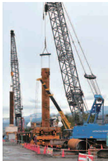
水橋田伏高架橋工事での回転杭施工状況
