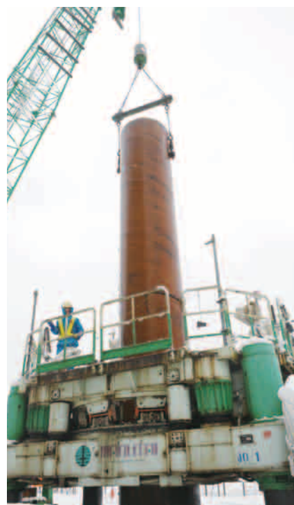
低騒音・低振動施工に加え、周辺地盤を緩めないため、近接工事に適した工法
