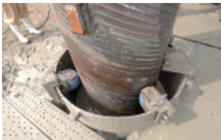
口元管と補助治具の使用で鉛直性を確保する
