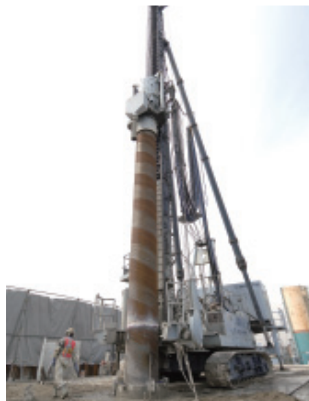
同時沈設方式による施工状況
