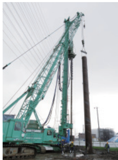
後沈設方式による施工状況
