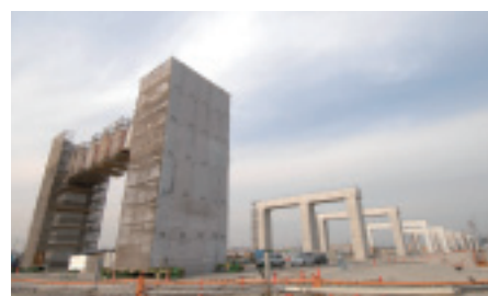
寝屋川市付近、高架部の工事が進む
