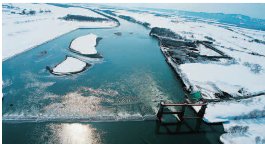
着工前の石狩川頭首工(2004年3月)
