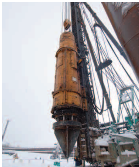
施工に使用された油圧ハンマー
