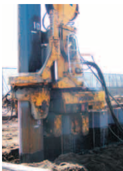
調整池矢板打設
