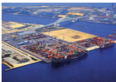
夢洲コンテナターミナルと夢舞大橋
