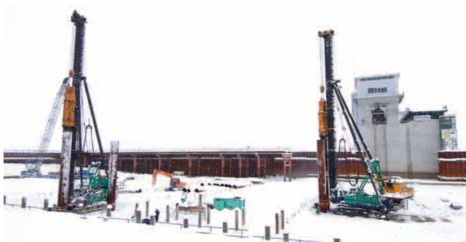
鋼管杭の打設状況
