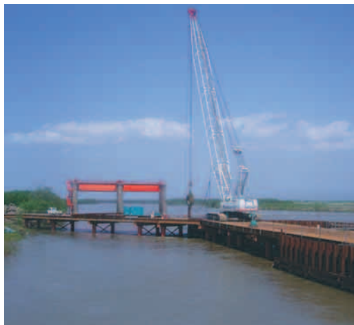
作業構台施工の様子。後方は現頭首工
