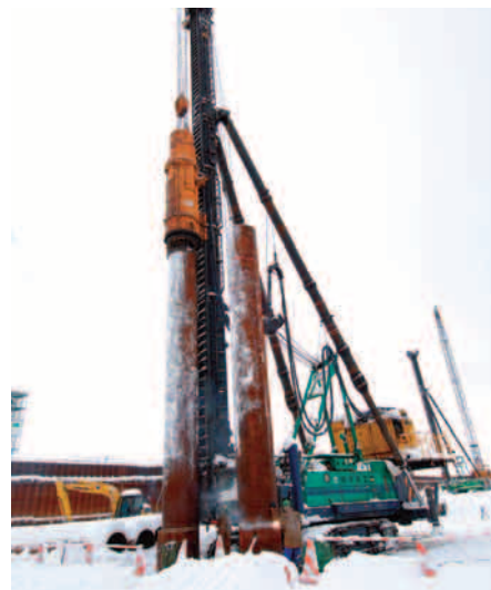
打撃施工中(左)および溶接中(右)の鋼管杭
