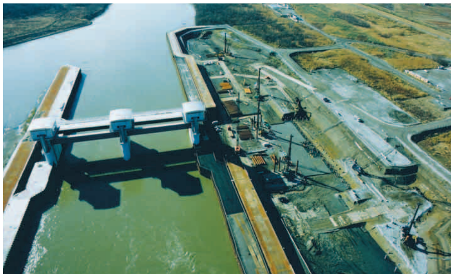
河道部中央から大規模な仮締切工が実施された
