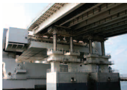
緩衝桁を跳ね上げる主ジャッキアップ装置
