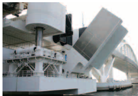
浮体橋の係留装置となる反力壁
