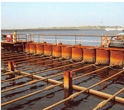
鋼管矢板二重壁式護岸（東京都 新海面処分場）
