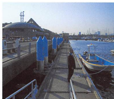
浮き桟橋係留杭 （東京都 夢の島マリーナ）
