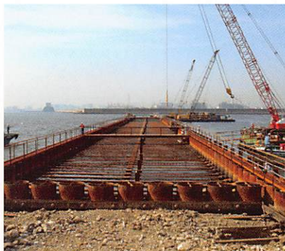
鋼管矢板二重壁式護岸（東京都 新海面処分場）
