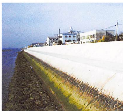
高潮堤防（広島県 天満川）
