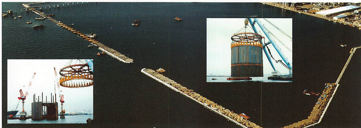
プレハブ鋼矢板セル工法（神奈川県 浮島埋立護岸）
