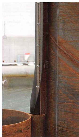
鋼管矢板：漏洩防止ゴム板付継手
