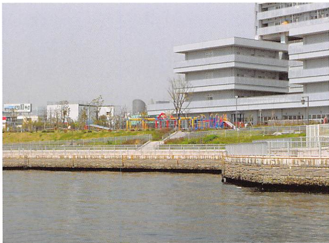
自立鋼管矢板式の前面に化粧パネル設置
