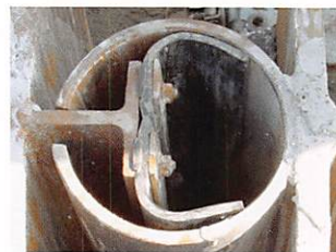
打設後の嵌合状況
