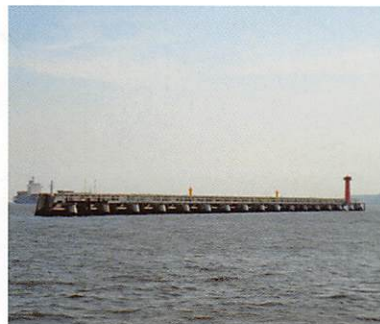
ジャケット式防波堤 （東京都 仮防波堤）
