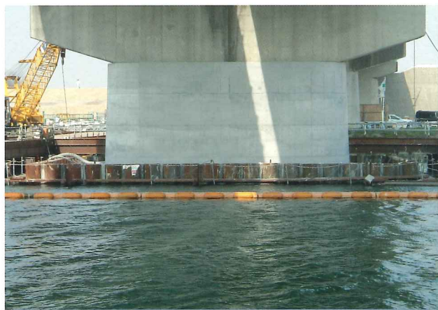
羽根倉橋耐震補強（埼玉県・さいたま市）
