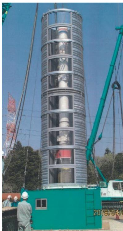
写真－3.1 防音装置の例
