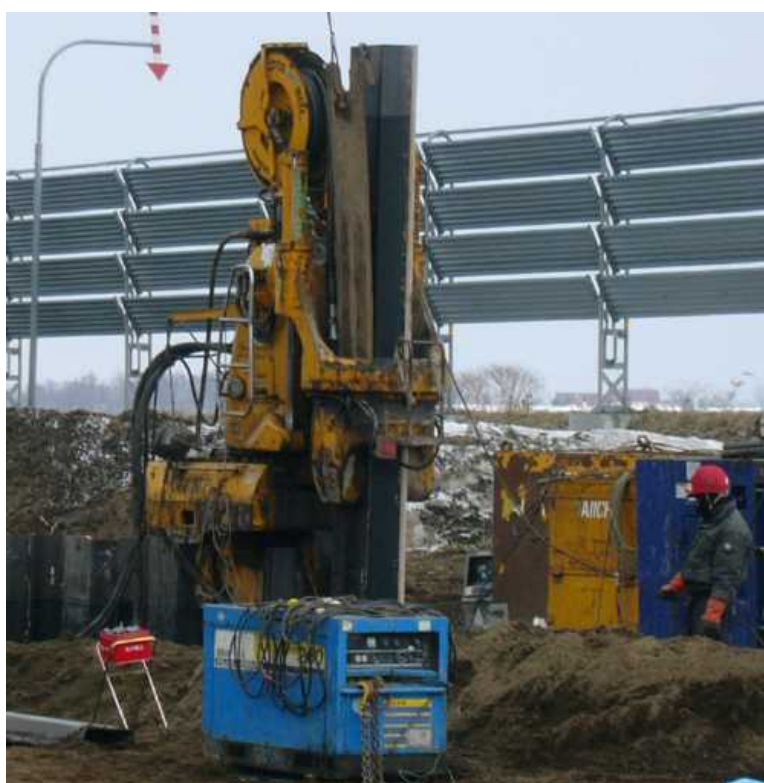
写－3 圧入機の施工例
