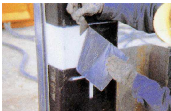
写－8 被覆部のはがし
