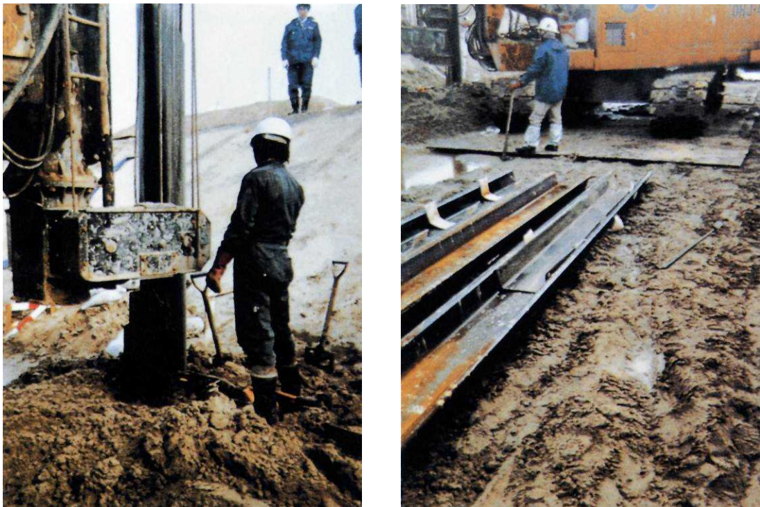
写-4 防護板による施工例
