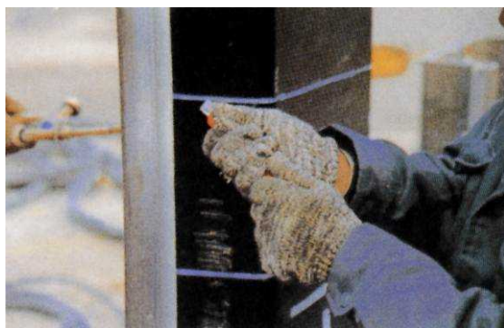
写－6 カッターによる切り欠き
