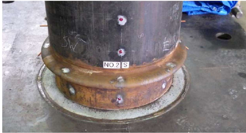
写真 2.7 解体前の試験体 (Case3)
