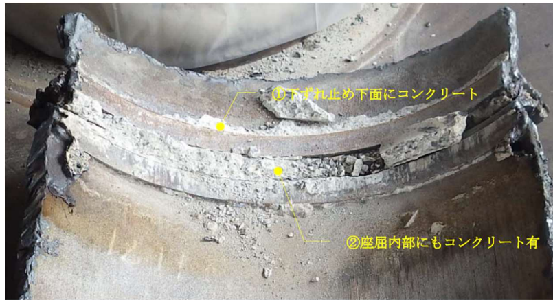
写真 2.8 解体後の試験体 (Case3：鋼管内面の状況)
