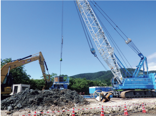
■先行掘削のケーシング建込み状況
