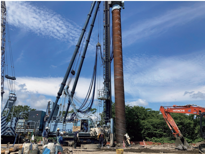
■鋼管ソイルセメント杭の建込み状況
