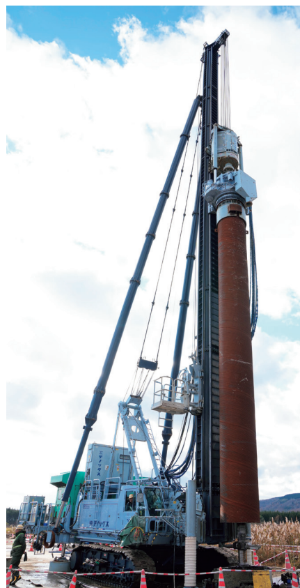
■ 鋼管ソイルセメント杭の施工状況
