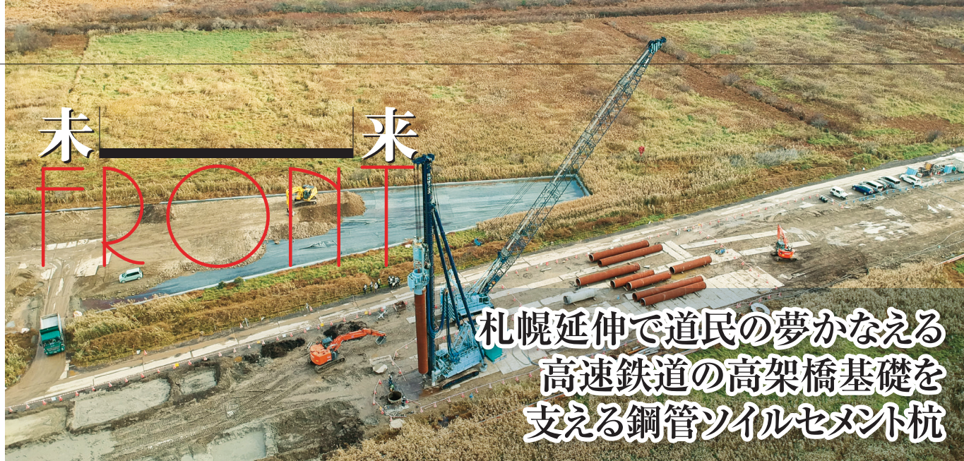
■長万部工区「静狩路盤工区」の施工状況
