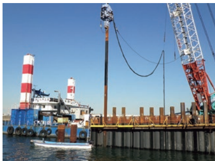
■パイプロハンマによる遮水鋼矢板の打設状況※10
