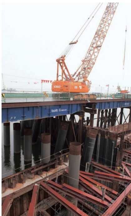
■鋼管矢板による締切と直杭・斜杭を併用した東側締切堤の現況
