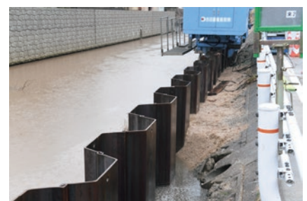
■圧入後の鋼矢板の状況
