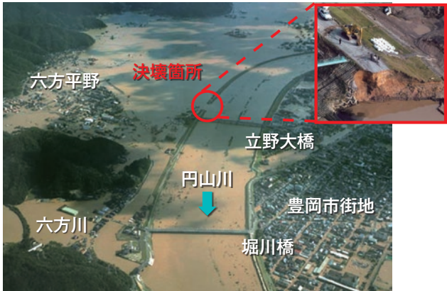
■平成16年10月23日、円山川立野地区の堤防決壊の状況
