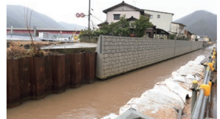
■景観に配慮した化粧型枠を用いた上部工パラペット
