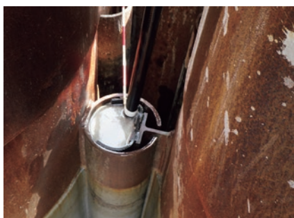
■鋼管矢板継手のモルタル封入状況※12
