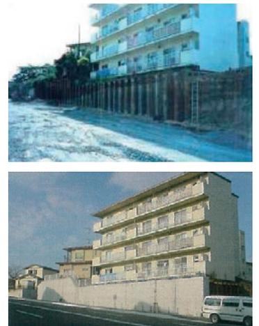
写真5.2 場所打ちコンクリートを用いた施工事例
