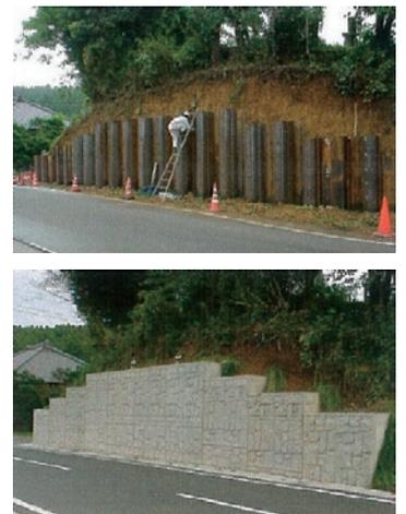
写真5.1 コンクリートパネルを用いた施工事例
