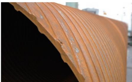
鋼管とソイルセメントの十分な付着力を確保する
