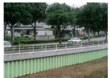
写真5.3 有機ライニング塗装を用いた施工事例
