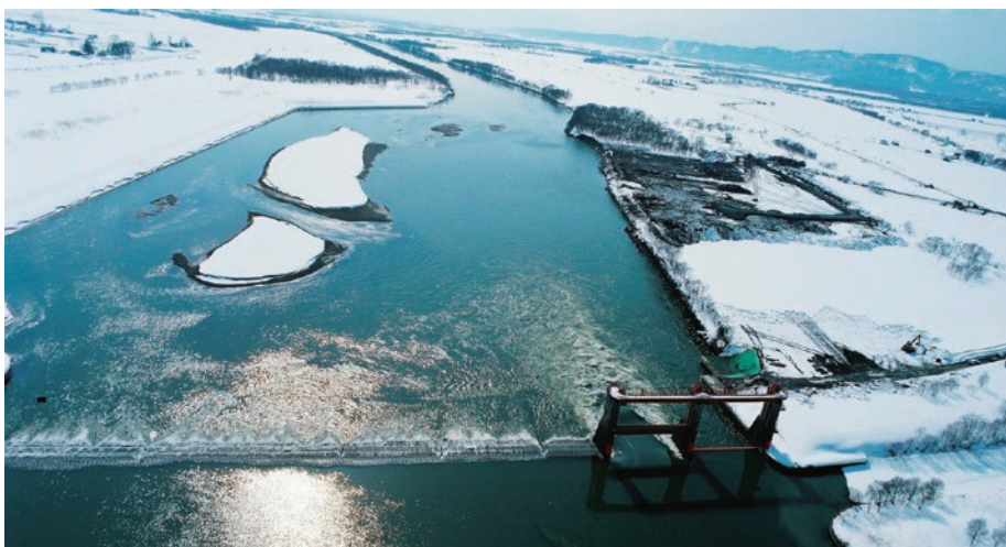
着工前の石狩川頭首工 (2004年3月)
