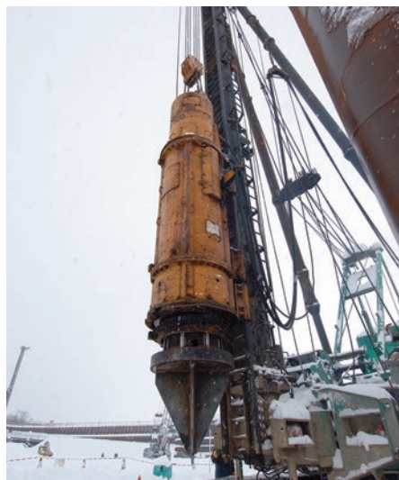
施工に使用された油圧ハンマー
