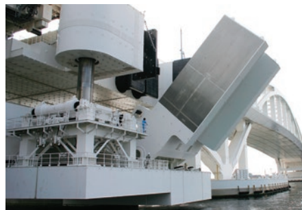
浮体橋の係留装置となる反力壁
