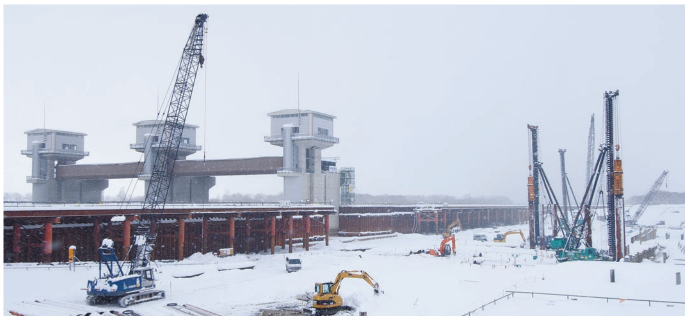
冬季・渇水期に急ピッチで進む建設現場全景
