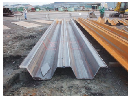
写真-5 引抜後の状況
