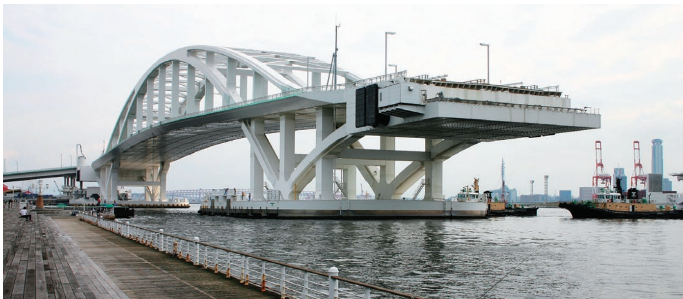
2006年10月29日開閉訓練時、開橋状態の夢舞大橋
