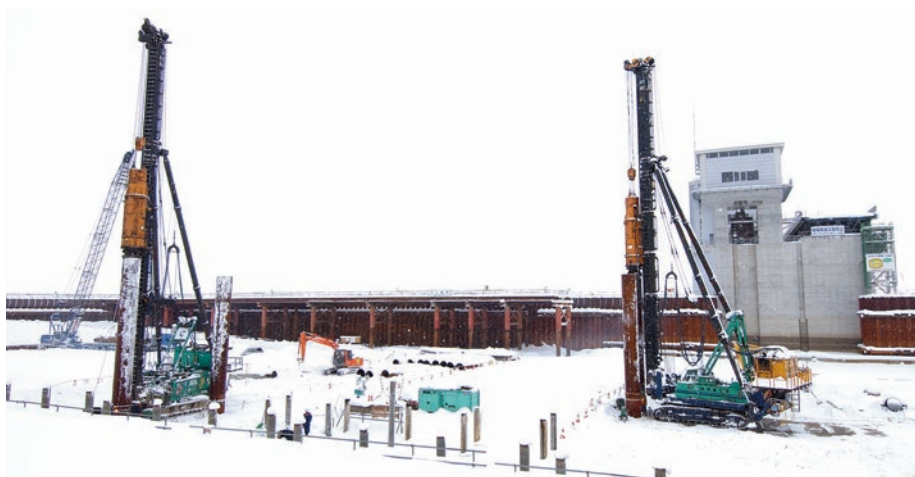
鋼管杭の打設状況
