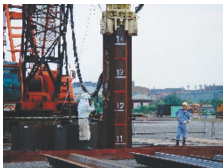
写真-4 打設状況 (U-1)
