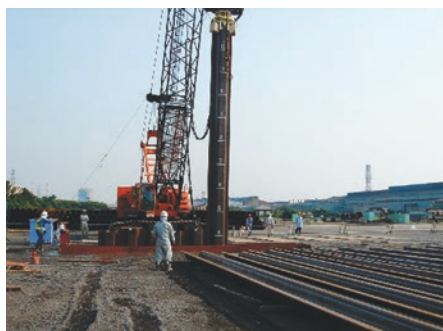
写真-3 打設状況 (A-30)
