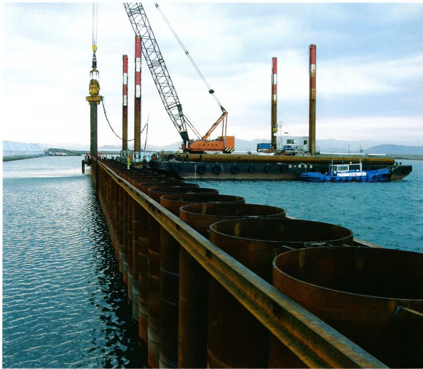
強靱かつ高い遮水性を有する鋼製遮水壁
