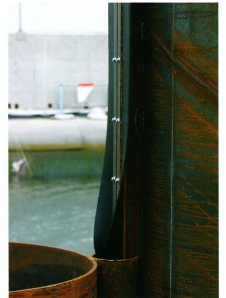
打設時の漏洩防止ゴム板の状況
