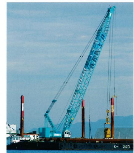
200t吊クローラクレーンと200kWバイプロハマにより打設が行われる
