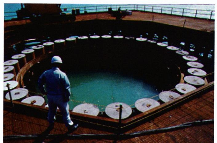
打設が完了した航路部の鋼管矢板基礎。琉球石灰岩層を支持地盤としている。
