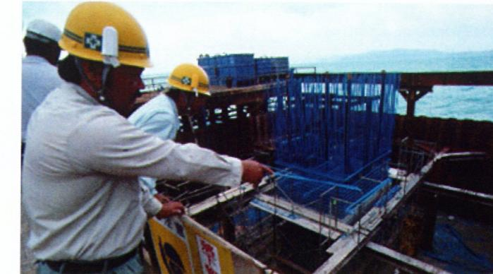
鋼管杭基礎打設が終了し、配筋作業が進む橋脚。
