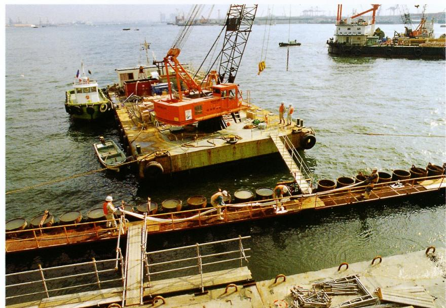
震災後、鋼管杭の耐震性が改めて認識され、護岸部分に多数採用されている。
