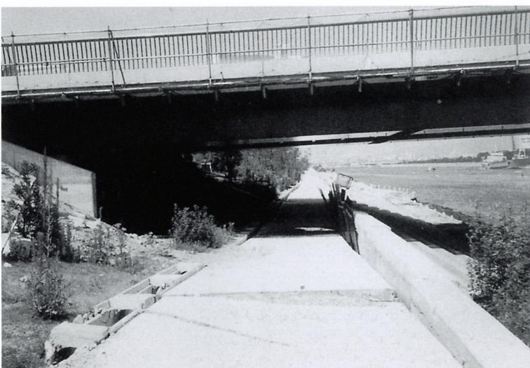
浜風大橋橋脚付近。岸壁の側方移動が見られる
