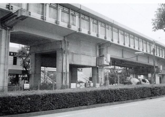
崩壊した新幹線の架橋部分。補修された部分のコンクリートが新しい。
