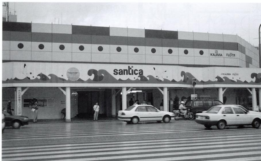
三宮駅では9階建ての駅ビルが崩壊。地階と1階を補強して残し、2~3階を暫定的に再建した。現在は鉄骨10階建ての本格再建へ向け準備が進む。
