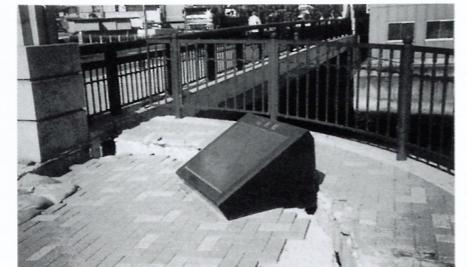
高松橋／钢管矢板自立壁の上。橋と縁が切れて地割が見られる
