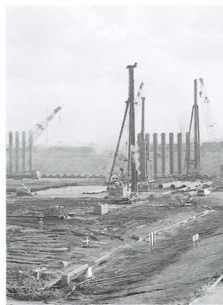
▲そもそも現場は、埋立造成地であり、シルト層主体の軟弱地盤であった。そのため山留材として施工性、安全性、経済性にすぐれた鋼管矢板〔φ1,000～φ1,200 mm × t12～t25 × l 33～43m(3本継ぎ)〕を使用した。使用量はφ1,000=436本、φ1,200=431本、合計867本、総重量16,700トンに達している。
