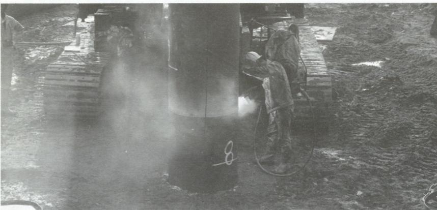
流れるのは、芭蕉が「五月雨をあつめてはやし最上川」と詠んだその川である。が、五月はすでに過ぎ去り、芭蕉の立っていた場所とも違い、ただゆるやかな流れが続くのみである。両岸では、杭打ち作業が進められている。1本打ち込むごとに、溶接作業が行なわれる。杭は3本継ぎで打ち込まれ、2~3本/日のピッチで作業が続けられている。須川橋下部工事現場でも、作業は順調に進められていた。その現場には、杭打ち作業中に堀り出された、巨大な木の根が片隅に放り出されていた。永い眠りから突然起こされて、さぞ不機嫌なことだろうと、つい勝手な想像をしてしまった。
