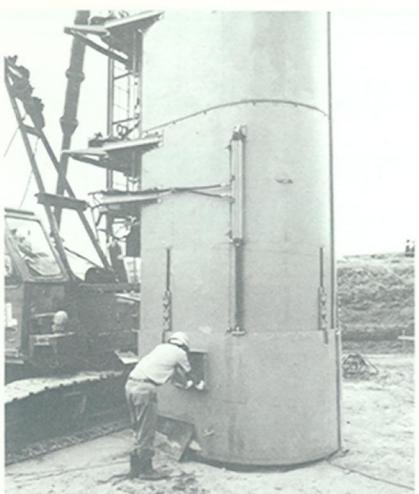
写真-2 下部カバーおよび監視用窓
