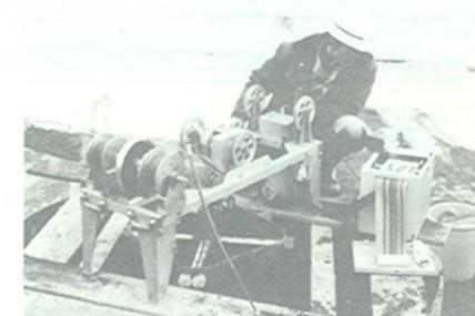
TBW工法などにより掘削された泥水中の溝壁の形状および精度を確認するため、超音波を応用した溝壁測定器を開発。さらに場所打ちぐいの精度管理に適する測定器の開発も行ない、実用化している。
