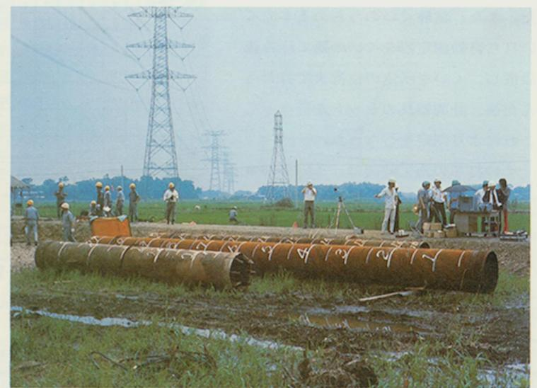
測定に先立ち、まず施工機械等の安全性を確保するために、切込碎石(0~40mm)を現地盤上に厚さ約70cmで敷きならし、締め固めを行ない、この碎石面を足場としてくい打ち作業を行なつた。
