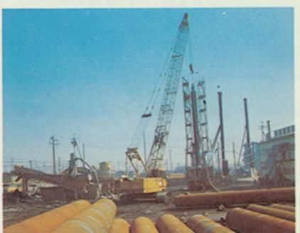
支持層の決定にあたっては、深度20m～25mに存在するN値50の砂礫層では予定建築物が高層であり、単位平方メートル当たりにかかる荷重がかなり大きく、中間層の圧密沈下も考えられるので、最終的には、深度37m以下の砂礫層とした。
