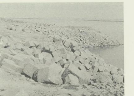
写真-6 洗掘防止用の捨石したジャムナ河河岸点の視察とそこで行なっているボーリング調査を見ることであったので、一度はヘリコプターでジャムナ河を上から視察したこと、および、一泊二日でArichaおよびShirajganjのボーリング地点を訪れたこと、とこの二度にわたって小旅行に出かける機会をもった。ジャムナ河は、乾期とはいえさすがに大きく、日本人のわれわれには想像を絶する大きさである。ボーリング地点
