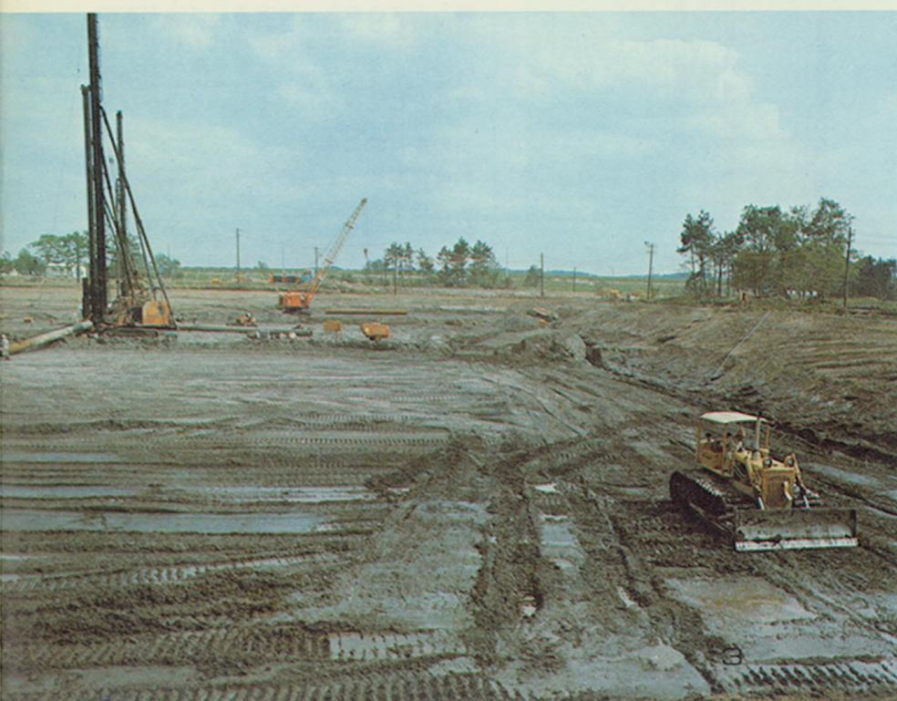
地盤の劣悪さに加えて、各設備の荷重がきわめて大きい。たとえば、沈砂池はR・C構造でカベ厚を1mもとつてあるため数100トンにも達する。また、ポンプ、プロアなどの設備だけでもひとつのユニット単位重量が10トン近くになる。とくにポンプは面積が小さいため、単位平米当りの重量がひじょうに大きい。
