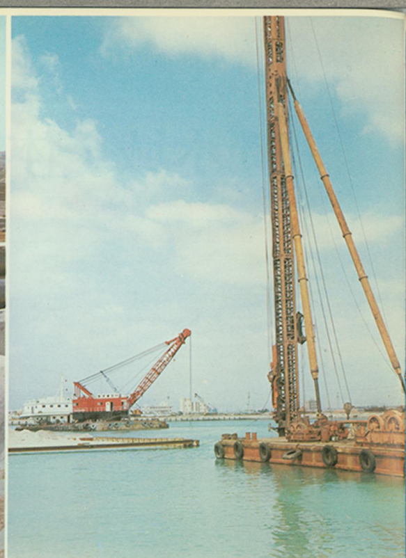
鋼管矢板の打ち込み
