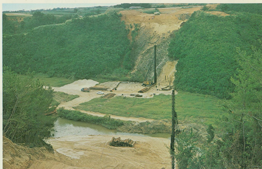
福地川橋ぐい打ち現場
