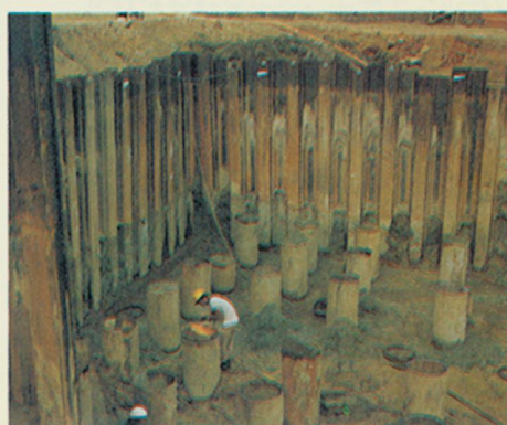
▲狭いスペースのくい打ち ◀伊芸高架橋現場 ▼くい頭処理
