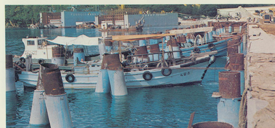
打込みを終えた鋼管ぐい群
