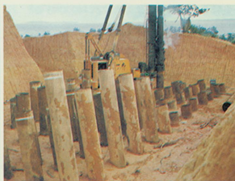
▲狭いスペースのくい打ち ◀伊芸高架橋現場 ▼くい頭処理
