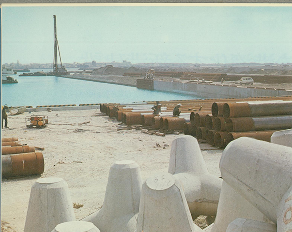
建設すむ新港工事現場
