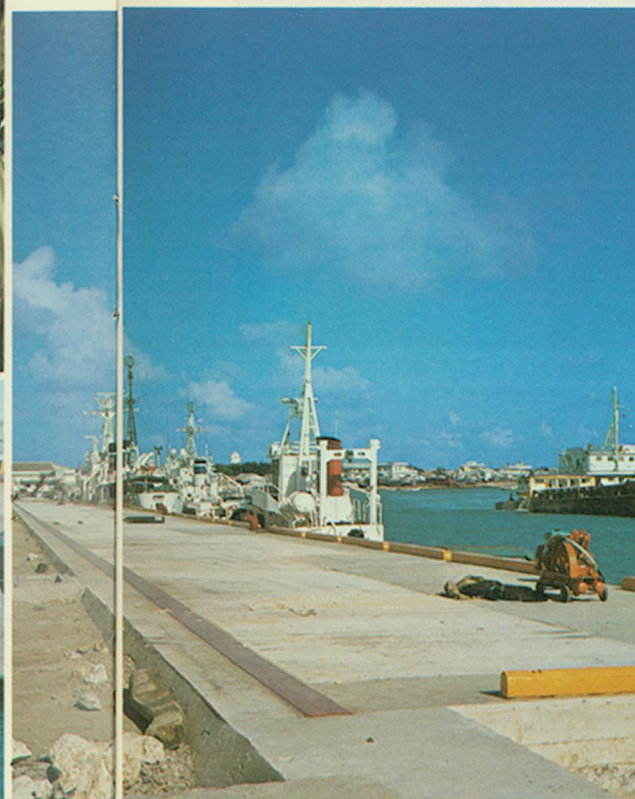
すでに船が停泊している新設岸壁
