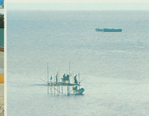
急ピッチですすむボーリング調査
