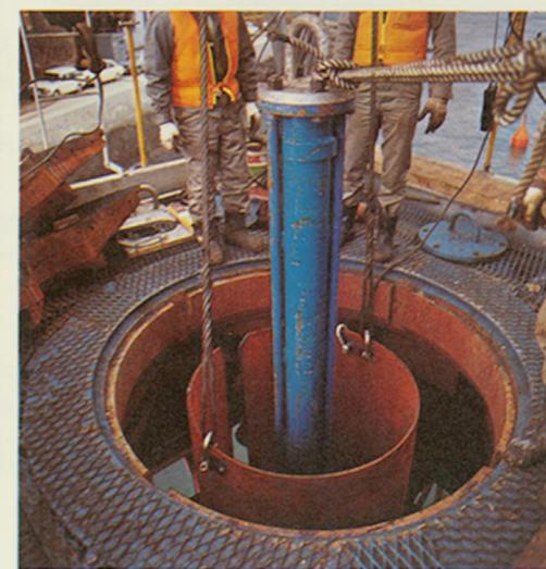
岩盤に孔を穿つ岩掘削機
