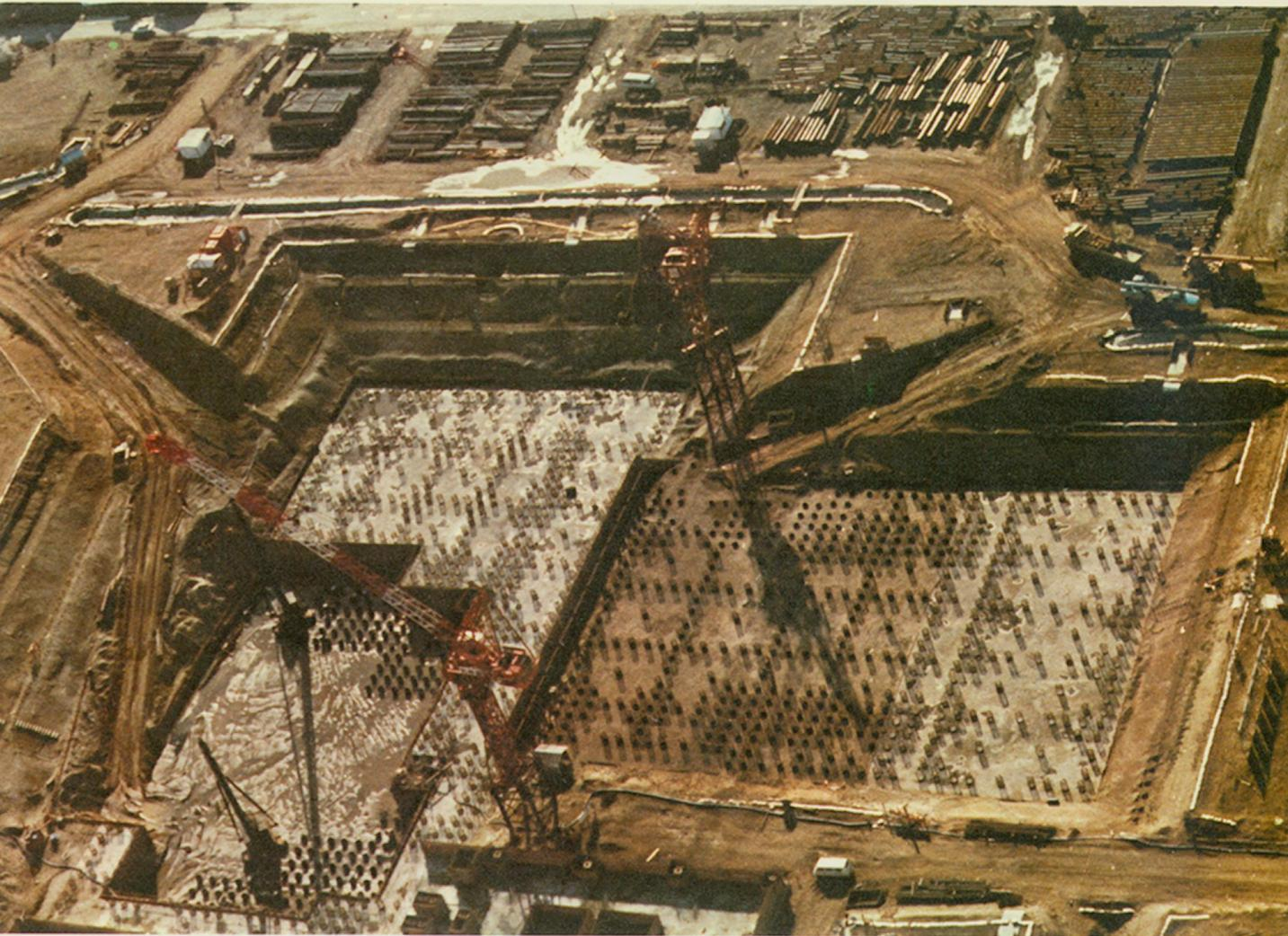
写真説明／くい打工事完了近い#6機タービン建屋ならびにボイラー基礎。三段に堀りわけ、ウエルポイントを配した状態がよくわかる。（上の写真は東電鹿島火力発電所第4期工事風景）
