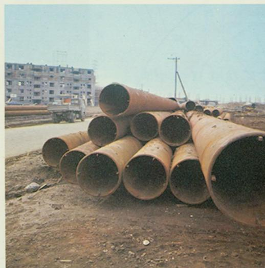
上中下／公団住宅における最新にして最大の鋼管杭基盤使用例として建設進む三郷団地
