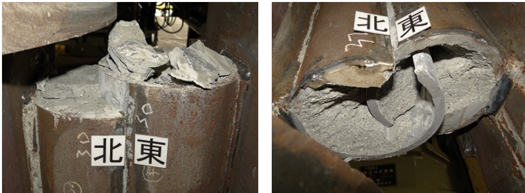
写真 2.3 試験終了後の継手上下のモルタルグラウトの状況
