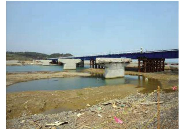
写真3.2.21 津波で上部工が流出した小泉大橋
