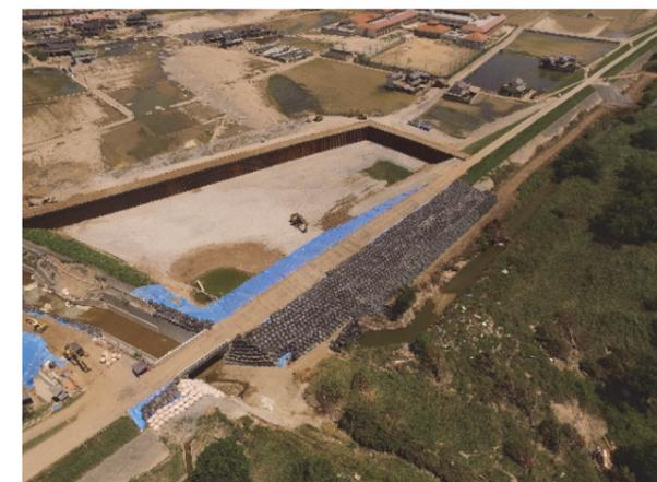
写真3.2.38 鋼矢板二重締切、完了状況
