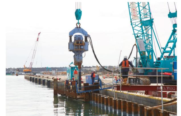
写真3.2.28 設計水深-6m岸壁 鋼矢板打設状況
