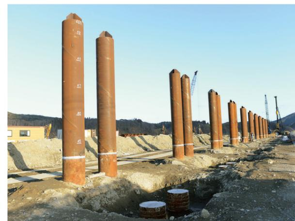
写真3.2.29 打設が終了した鋼管杭の施工状況
