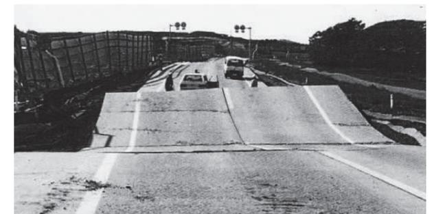
写真3.2.7 能代南バイパス被害状況(防災ネット東北(c)東北地方整備局)
