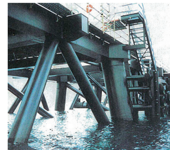
写真2.3.14 塗装工法 30) (写真提供：防食・補修工法研究会)
