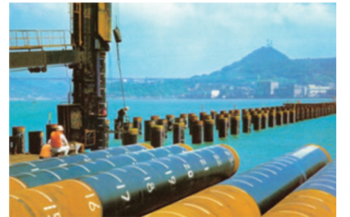
写真2.3.1 ポリエチレン被覆による重防食鋼管杭(黒色部位が被覆材) 7) (写真提供：防食・補修工法研究会)
