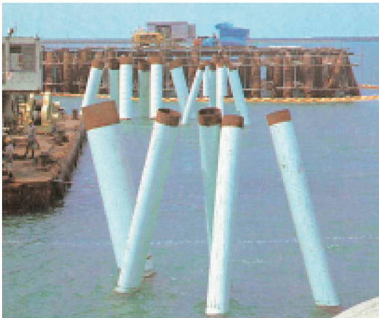
写真2.3.21 LNGバース部の鋼管杭 40)
