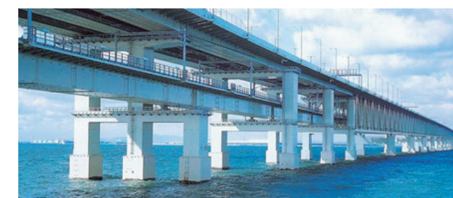
写真2.3.15 超厚膜型被覆工法の例（関西国際空港連絡橋） 30) (写真提供：防食・補修工法研究会)
