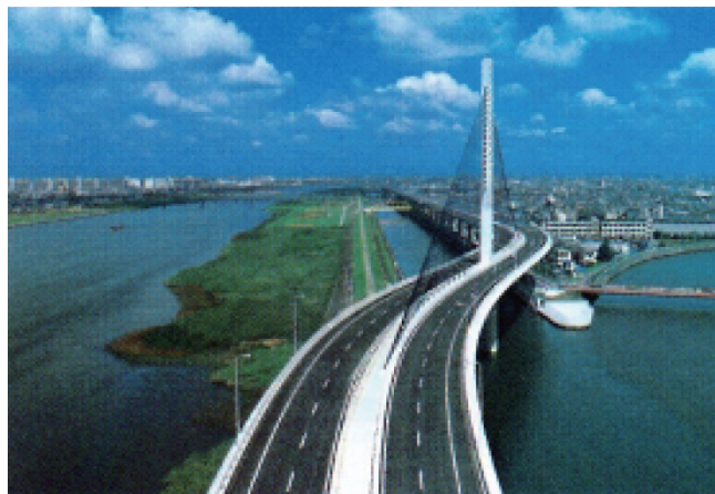
写真2.3.8 首都高速道路 首都高速中央環状線 葛飾江戸川線 22)
