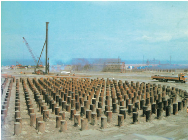
写真2.3.20 LNGタンク部の鋼管杭 40)
