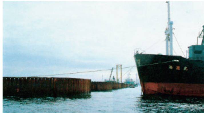
写真2.3.6 東京湾横断道路 木更津人工島橋梁接続部の鋼矢板セル 14)
