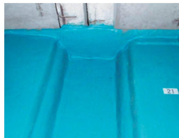
写真2.3.13 水中硬化型被覆工法（バテタイプの鋼矢板への施工例） 30) (写真提供：防食・補修工法研究会)
