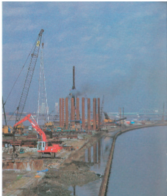
写真2.3.9 首都高速道路 KE線高架橋の小判形鋼管矢板基礎打設状況 23)
