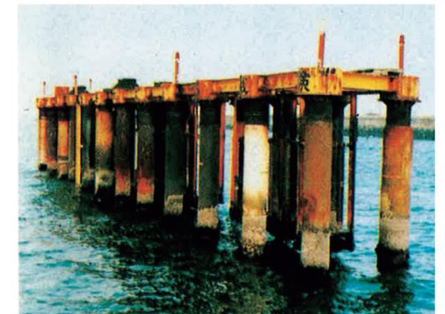
写真2.2.20 千葉沖における防食鋼管杭暴露状況<sup>53)</sup>
