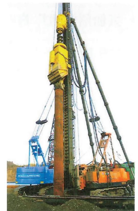
写真2.2.2 中掘り杭打ち機<sup>(1)</sup>
