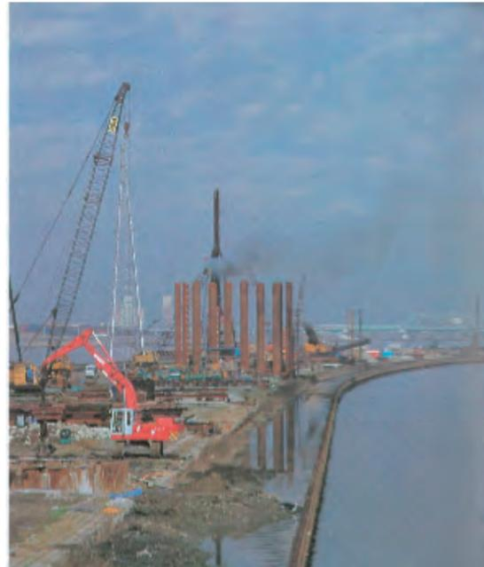
写真2.3.9 首都高速道路 KE線高架橋の小判形鋼管矢板基礎打設状況<sup>23)</sup>
