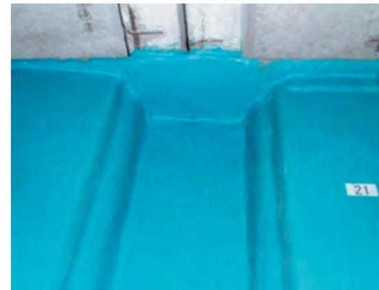
写真2.3.13 水中硬化型被覆工法 (パテタイプの鋼矢板への施工例)<sup>30)</sup>
