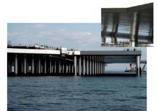
写真2.5.14 チタンカバープレートが採用された新滑走路横橋部<sup>31)</sup>
