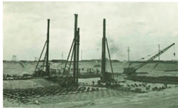
写真2.2.24 東京電力川崎火力発電所 鋼管杭打設状況<sup>63)</sup>
