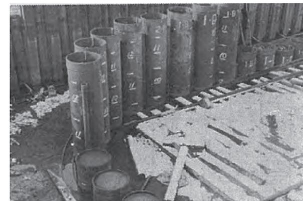
写真2.1.6 鋼管矢板基礎全景<sup>11)</sup>
