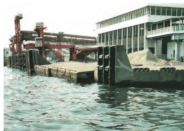
写真2.4.14 東神戸フェリー埠頭(ケーソン護岸が崩壊した岸壁の全景)<sup>35)</sup>
