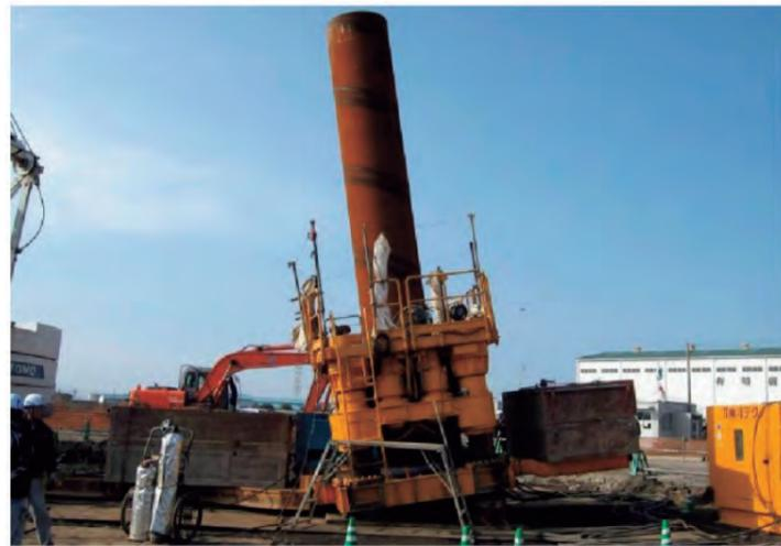
写真 2.5.3 斜杭の施工状況<sup>6)</sup>
