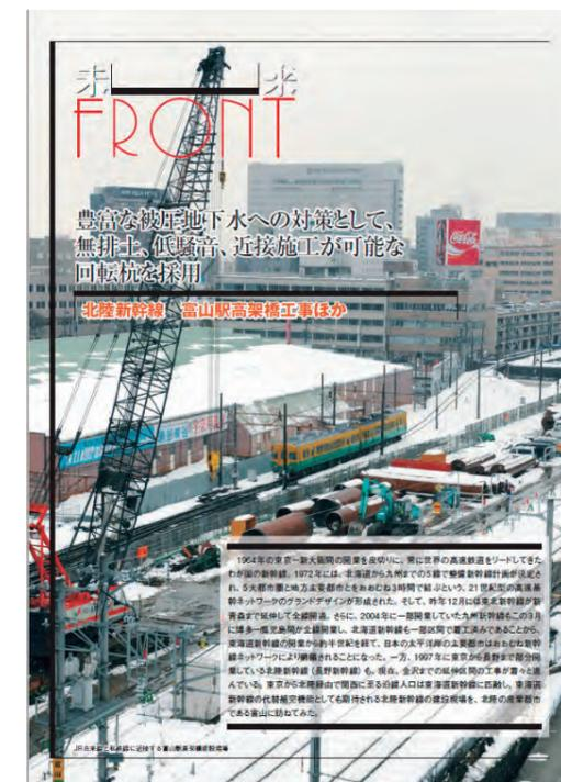
図2.5.4 北陸新幹線 富山駅高架橋工事の回転杭工事の様子<sup>22)</sup>
