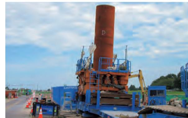
写真2.6.3 北陸新幹線延伸工事(金沢～敦賀間)小松木場湯高架橋の斜杭施工<sup>25)</sup>
