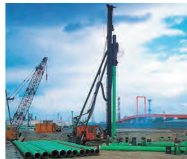
写真2.2.10 ネガティブフリクション低減杭(保護層付きSL杭)<sup>33)</sup>
