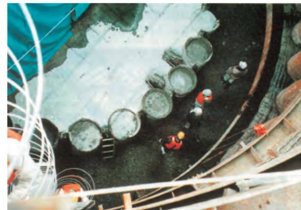
写真2.4.6 西宮大橋 P3橋脚頂版コンクリートひび割れ調査の様子<sup>24)</sup>
