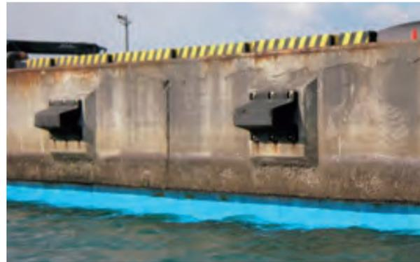
写真2.3.11 モルタル被覆工法の岸壁への適用例<sup>30)</sup>
