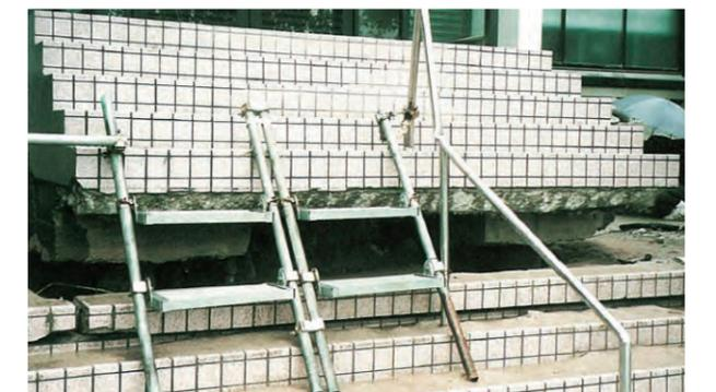
写真2.4.19 周辺地盤の沈下による階段のずれ<sup>41)</sup>
