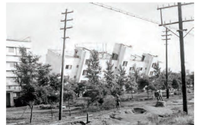
写真2.1.13 液状化により傾いた県営川岸町アパート<sup>65)</sup>
