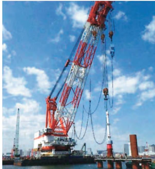
写真2.6.17 東京国際クルーズターミナル 鋼管杭打設状況<sup>42)</sup>
