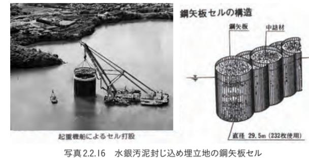
写真2.2.16 水銀汚泥封じ込め埋地の鋼矢板セル
