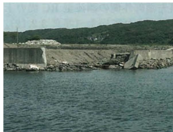
写真2.6.7 久慈漁港の被災状況<sup>31)</sup>
