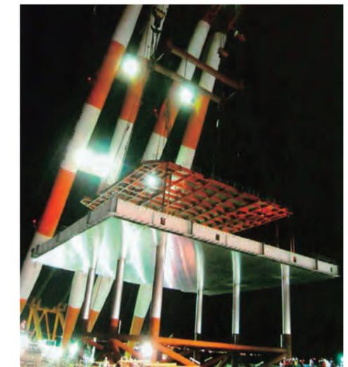
写真2.5.13 横橋部ジャケットの最終取り付け<sup>32)</sup>
