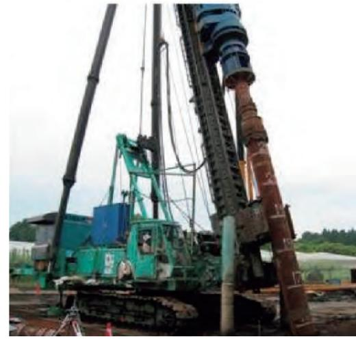
表 2.5.2 鋼管杭の機械式継手の例<sup>2)</sup>を引用編集
