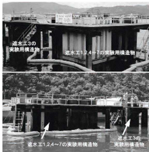
写真2.5.12 実海域遮水性確認のための構造物外観<sup>24)</sup>
