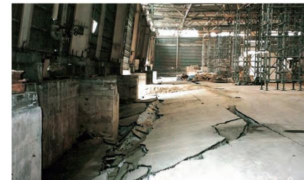
写真2.4.18 フーチングの移動により陥没した床版<sup>41)</sup>
