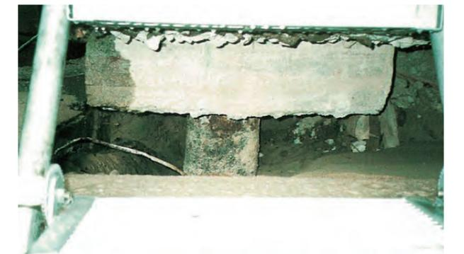
写真2.4.20 露出し傾斜した鋼管杭<sup>41)</sup>
