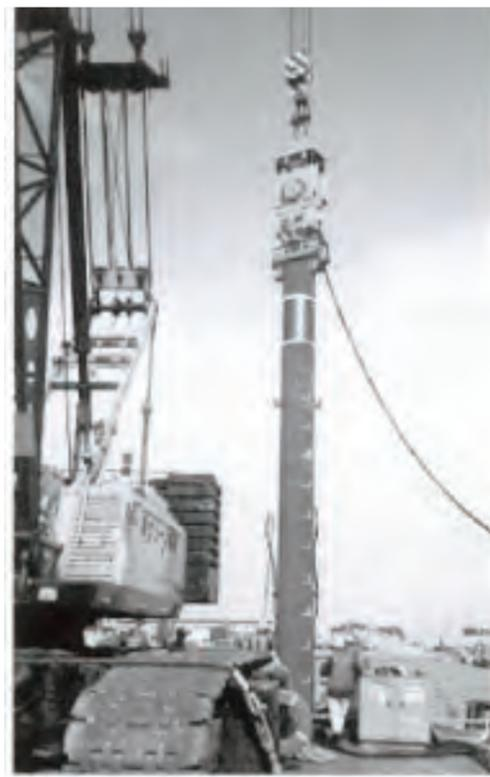
写真2.5.5 パイプロハンマ工法の施工風景<sup>10)</sup>
