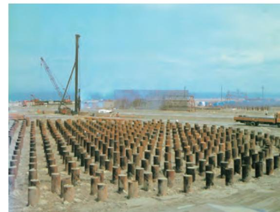
写真2.3.20 LNGタンク部の鋼管杭<sup>40)</sup>
