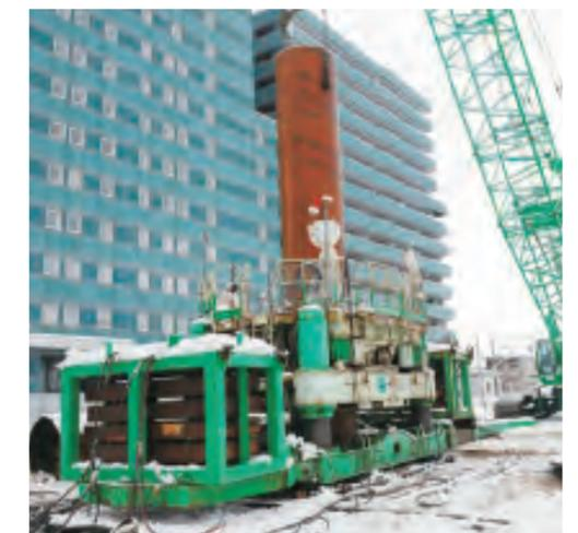
写真2.5.12 鋼管矢板遮水壁の実海域実験の様子<sup>27)</sup>
