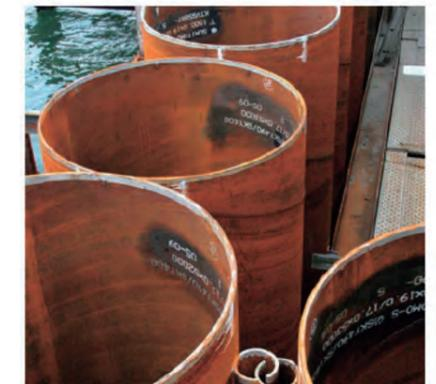
図2.5.3 東京港臨海大橋(現 東京ゲートブリッジ)で採用された縞鋼管高耐力継手<sup>14)</sup>
