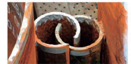
縞鋼管継手嵌合状況
