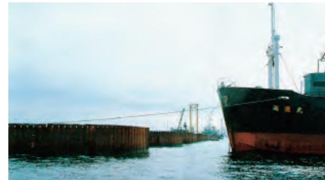
写真2.3.6 東京湾横断道路 木更津人工島橋梁接続部の鋼矢板セル<sup>14)</sup>
