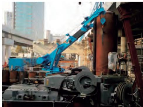
写真2.6.2 高速1号羽田線更新工事(東品川栈橋・鮫洲埋立部)での低空頭圧入機での施工の様子<sup>24)</sup>
