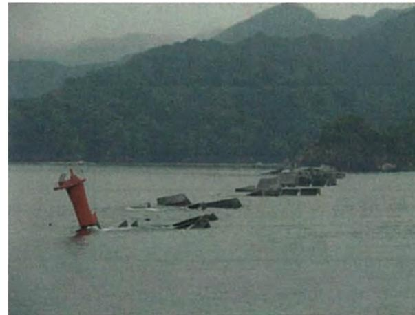
写真2.6.5 釜石湾口防波堤の被害<sup>31)</sup>
