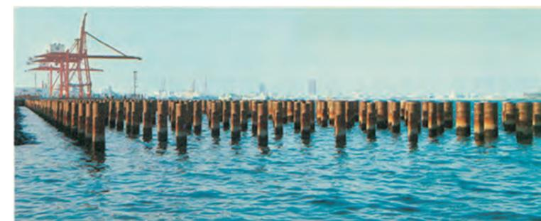
写真2.2.11 大井コンテナバース鋼管杭<sup>37)</sup>
