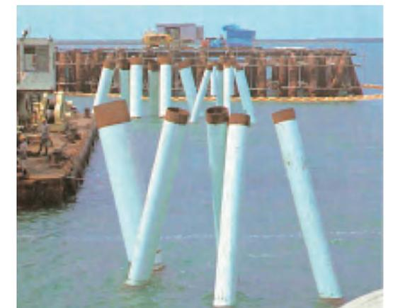
写真2.3.21 LNGバース部の鋼管杭<sup>40)</sup>
