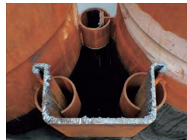
写真2.6.14 鋼管矢板と遮水鋼矢板による締切構造<sup>38)</sup>\*
