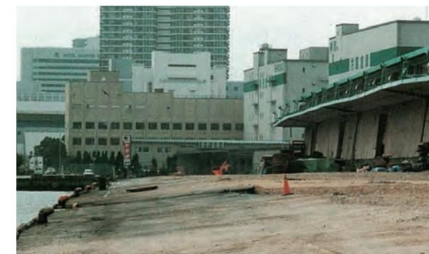
写真2.4.17 ケーソン岸壁の前傾による、鋼管杭基礎と構造物の傾き<sup>41)</sup>
