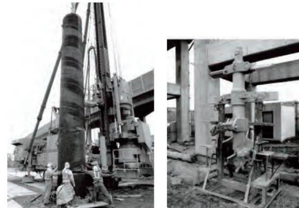
写真2.5.8 名古屋臨海高速鉄道西名古屋港線での鋼管ソイルセメント杭施工と掘削攪拌ヘッド<sup>18)</sup>
