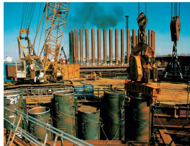
写真2.3.3 東京湾連絡橋基礎 鋼管矢板打設現場写真<sup>8)</sup>
