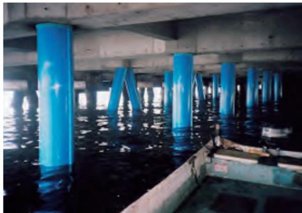
写真2.3.12 ベトロラタム被覆工法 鋼管杭橋への適用例<sup>30)</sup>
