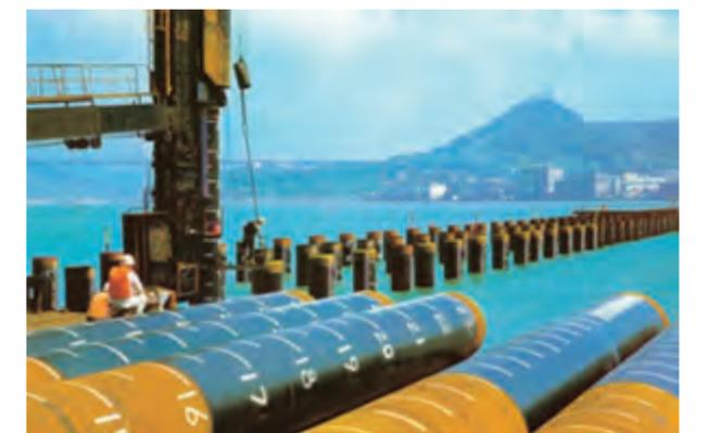
写真2.3.1 ポチエチレン被覆による重防食鋼管杭(黒色部位が被覆材)<sup>7)</sup>
