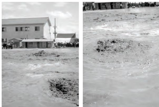
写真2.1.14 新潟明訓高校の校庭で発生した噴砂・湧水<sup>65)</sup>
