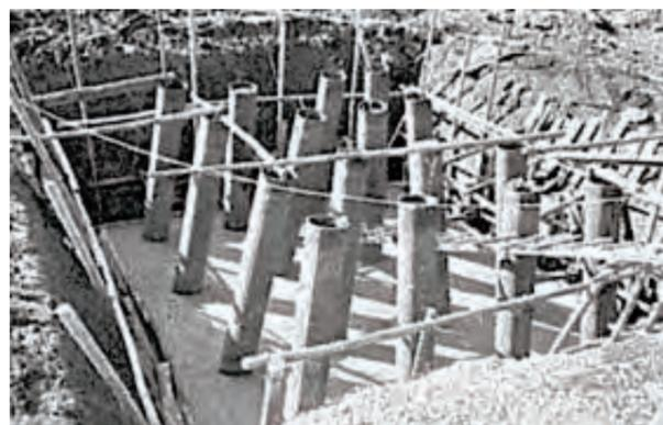
写真2.1.10 東海道新幹線 柳沢高架橋基礎杭<sup>34)</sup>
