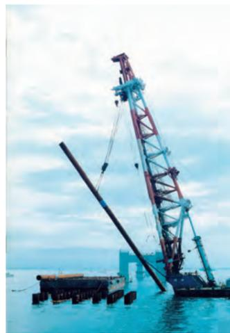
写真2.3.4 関西国際空港連絡橋基礎杭の打設風景<sup>10)</sup>
