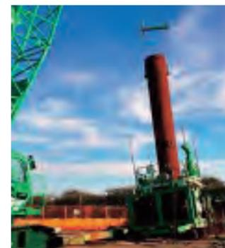
写真2.6.4 東海環状自動車道(大野神戸IC～大垣西IC)本線 ランプ橋の斜杭施工<sup>27)</sup>
