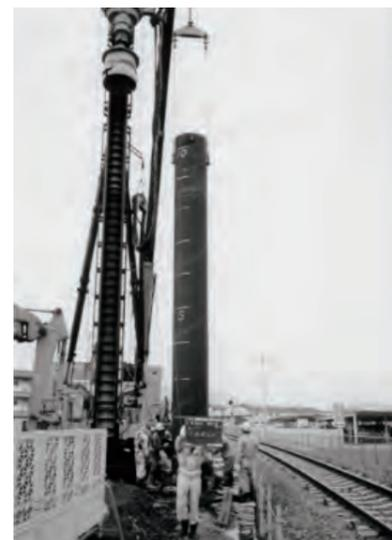
写真2.5.9 JR土讃線連続立体交差事業 高知駅高架橋基礎工事 鋼管ソイルセメント杭の建て込みの様子<sup>20)</sup>
