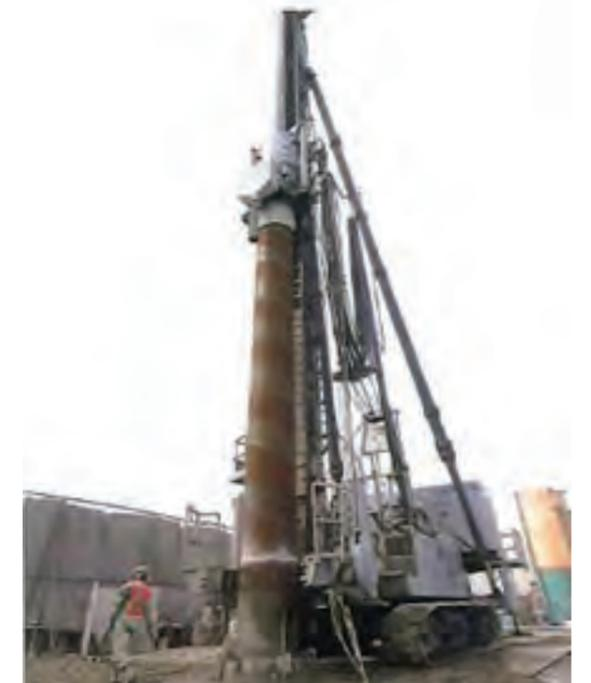
写真2.4.1 鋼管ソイルセメント杭工法 杭打ち機<sup>9)</sup>
