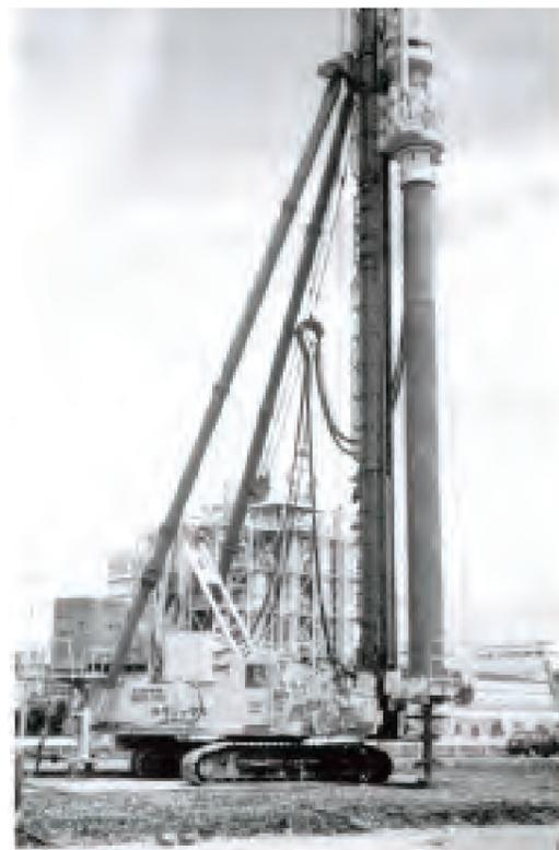
写真2.5.4 鋼管ソイルセメント杭工法の施工風景<sup>10)</sup>
