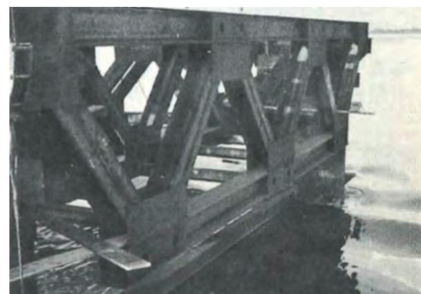
写真2.2.14 IHI知多ドッグ艦装ドルフィン(杭連結鉄骨支保工)<sup>40)</sup>
