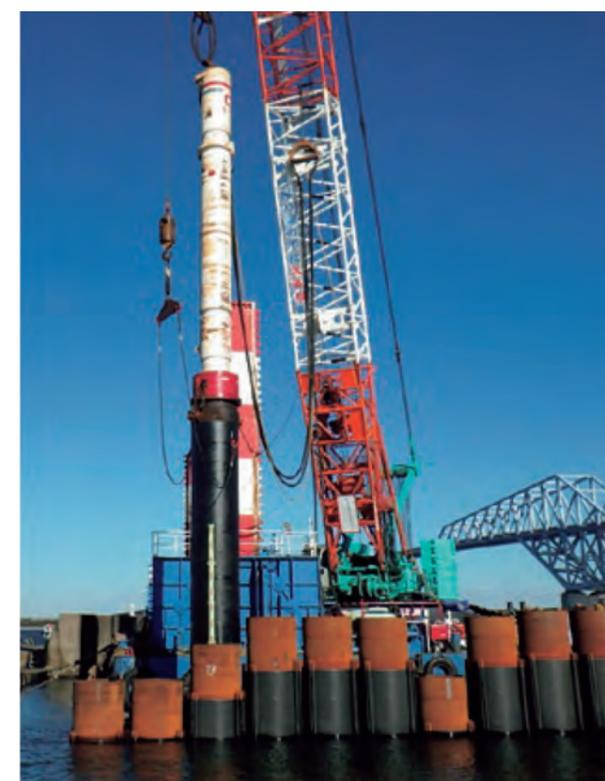
写真2.6.13 東側締切堤 油圧ハンマによる鋼管矢板の打設状況<sup>38)</sup>\*
