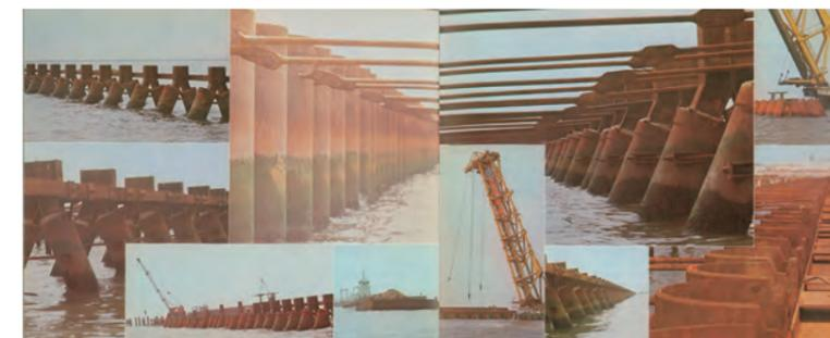
写真2.2.12 大阪港南港の鋼管杭・鋼管矢板<sup>38)</sup>
