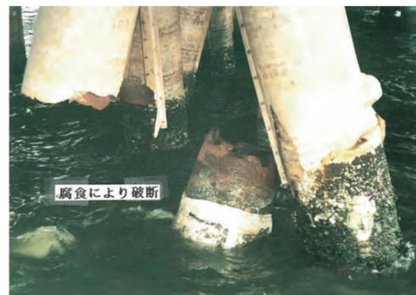
写真2.4.13 住吉浜町のサイロ岸壁(腐食により破断したと思われる鋼管杭)<sup>35)</sup>
