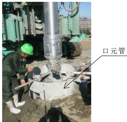
写真-2.1 口元管の設置例
